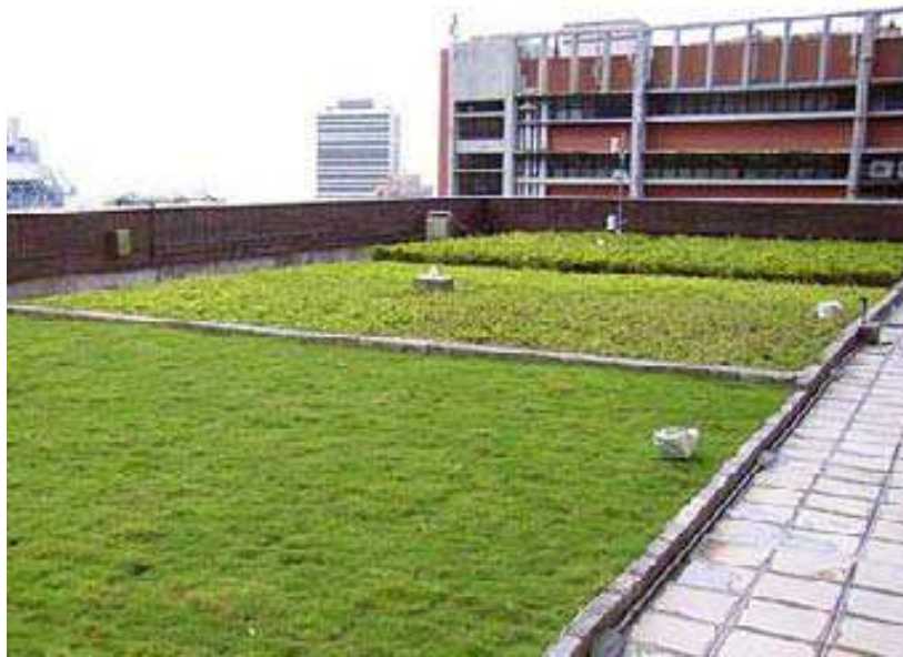
Figura 5. Telhado verde experimental instalado na Universidade de Hong Kong. Fonte: TOWNSHEND (2006).
