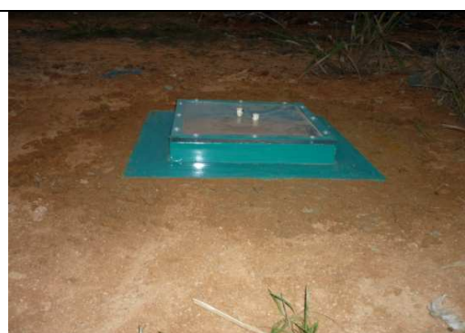
Figura 35 - Situação final da placa no solo
