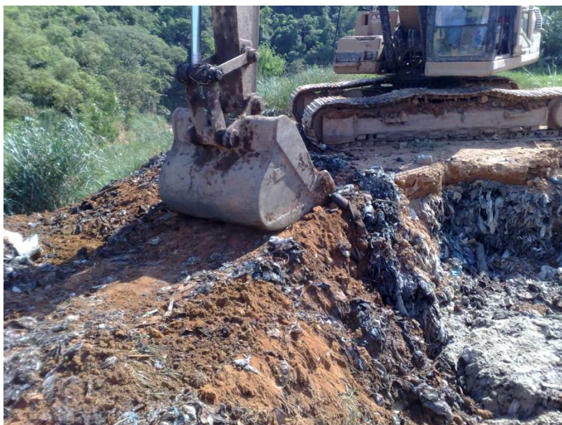
Figura 21 - Escavação da barreira capilar
