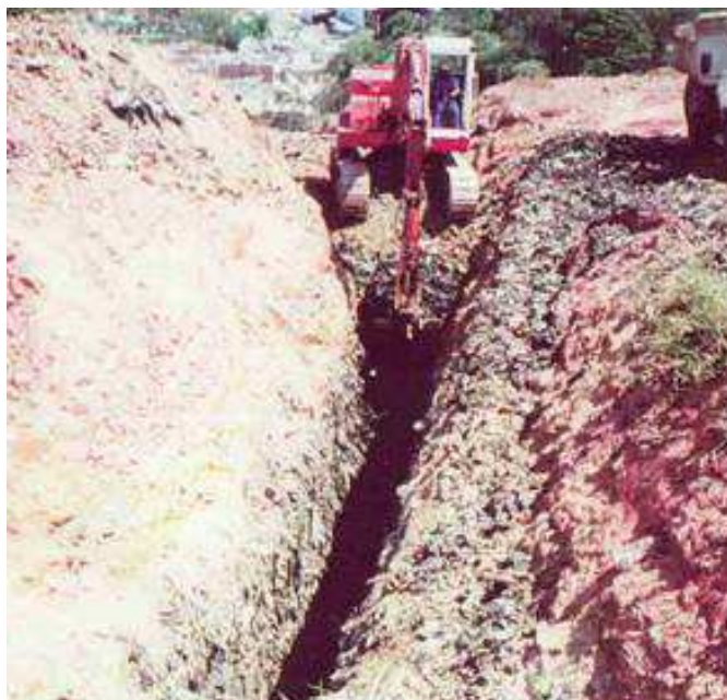
Figura 12 - Detalhe da execução de trincheira para a implantação de drenos transversais e longitudinais.
