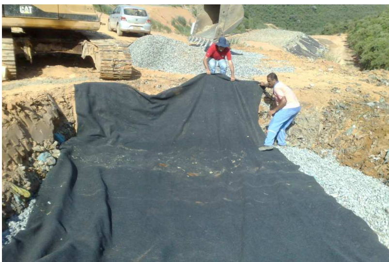
Figura 23 - Instalação da manta geotextil não tecido na camada capilar
