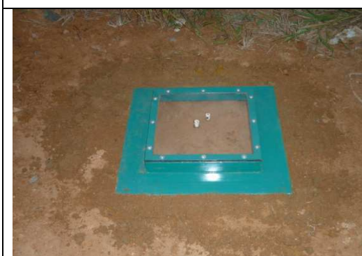
Figura 34 - Recomposição, compactação e umedecimento do solo de cobertura
