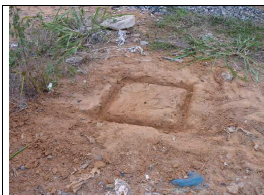
Figura 32 - Marcação e escavação manual para montagem da placa
