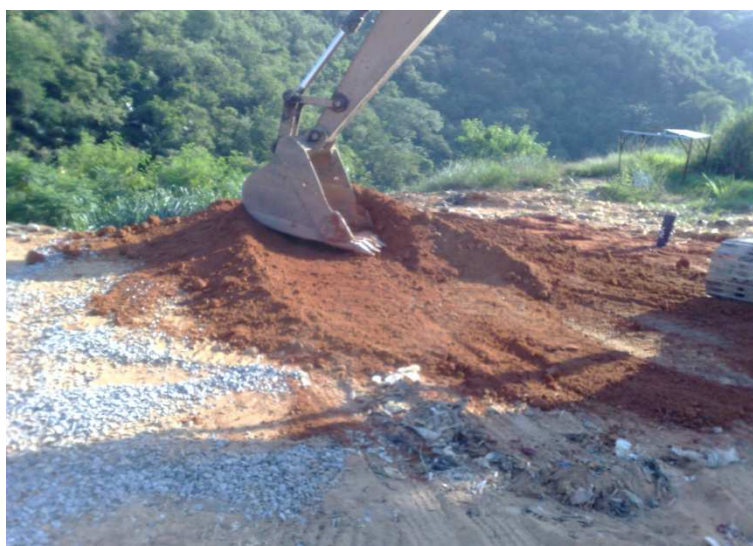
Figura 25 - Nivelamento do terreno e a compactação superior da barreira capilar.
