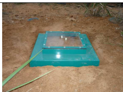
Figura 33 - Assentamento da placa e colocação de bentonita
