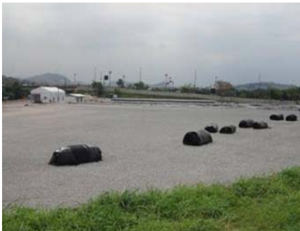
Célula pronta com as unidades Geotube Posicionadas
