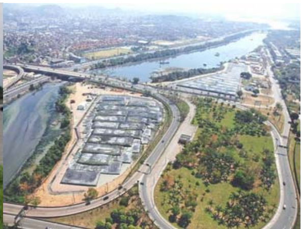
Áreas com as unidades Geotube em funcionamento
