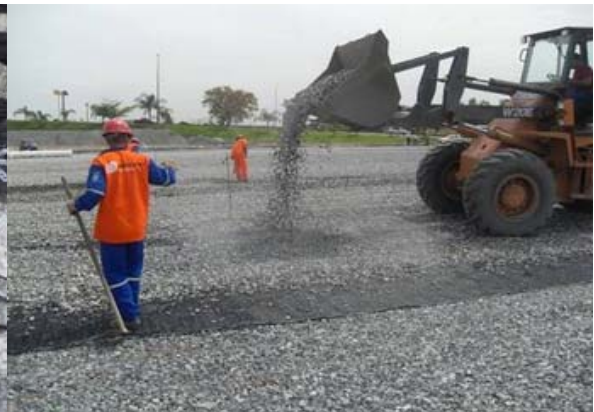
Nova camada de brita
