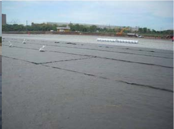
Instalação do geotextil naotecido de proteção da face superior da geomembrana
