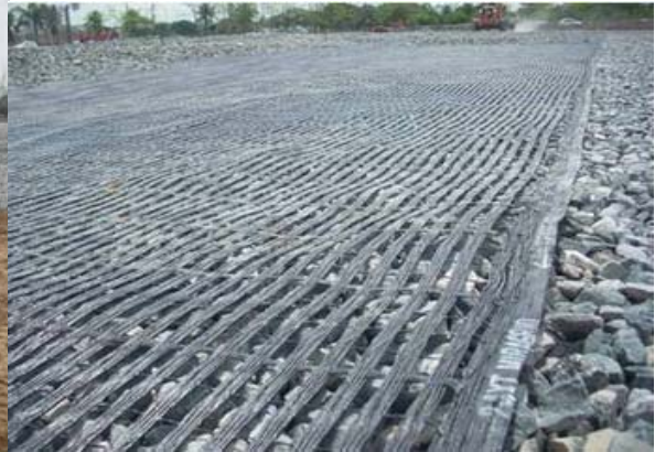
Instalação da Geogrelha
