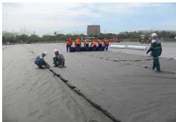
Instalação do geotextil não tecido de proteção da face inferior da geomembrana
