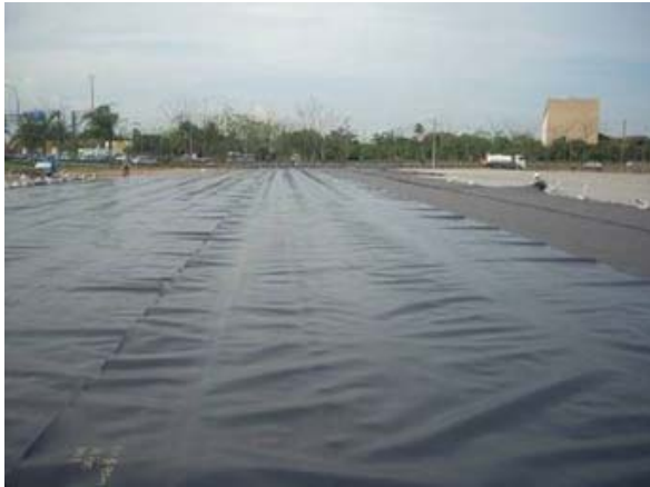
Instalação da Geomembrana
