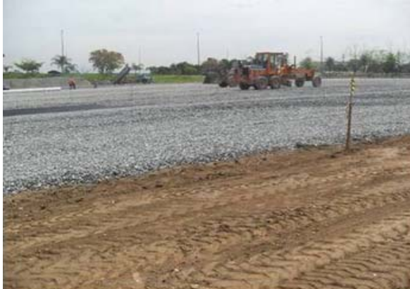
Nivelamento, compactação do solo e colocação da primeira camada de brita
