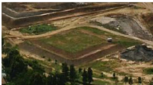
Figura 4.8: Vista do aterro sanitário experimental (fonte: SIMÕES ET AL, 2008)
