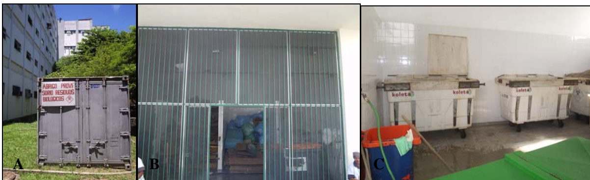
Figura 31- Fotos dos abrigos externos de resíduos biológicos dos laboratórios IBRAG. A) Abrigo provisório do PAPC e B e C) Abrigo externo de resíduos biológicos, comuns e recicláveis do onde são armazenados os resíduos do PAPC e HUPE.
