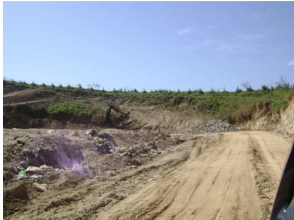
Figura 24 – Acesso a Frente de Trabalho – Aterro Sanitário de Pirai
