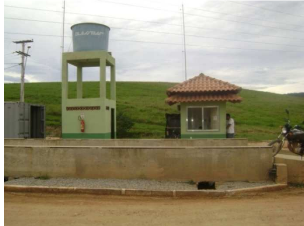
Figura 63 - Guarita e Plataforma da Balança Rodoviária
