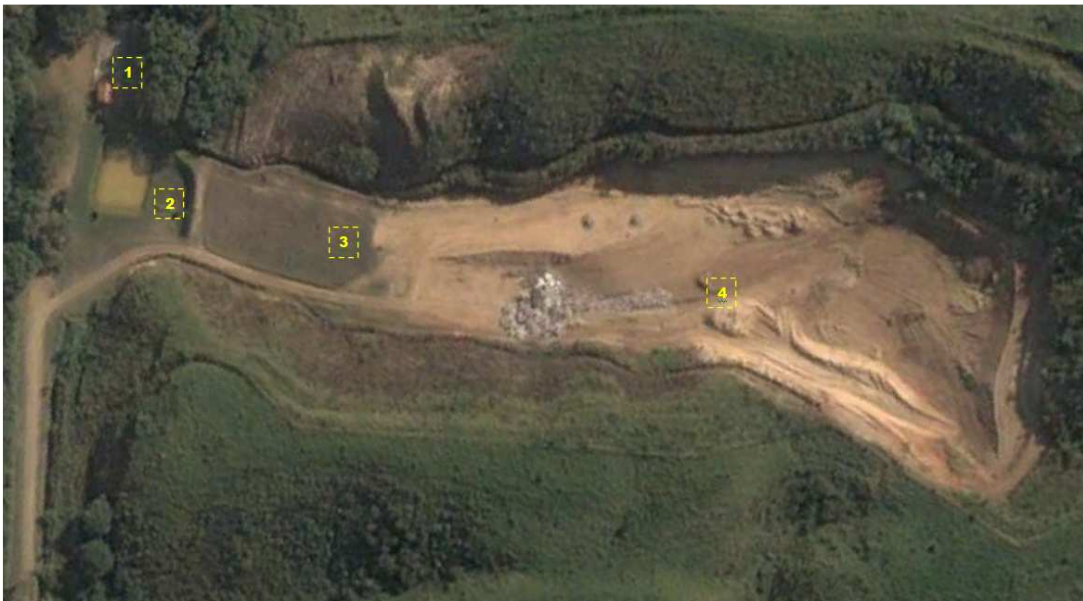
Figura 13 – Visão Geral – Aterro Sanitário de Pirai
