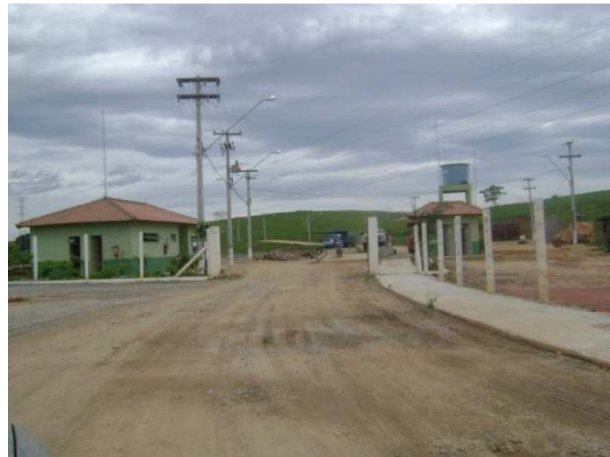
Figura 60 - Central de Tratamento de Resíduos de Macaé
