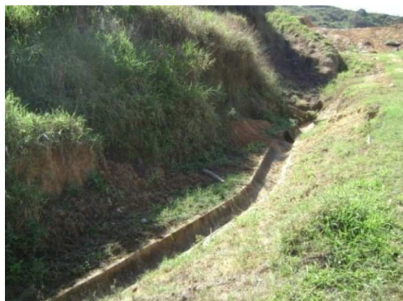
Figura 25 – Drenagem Pluvial – Aterro Sanitário de Pirai
