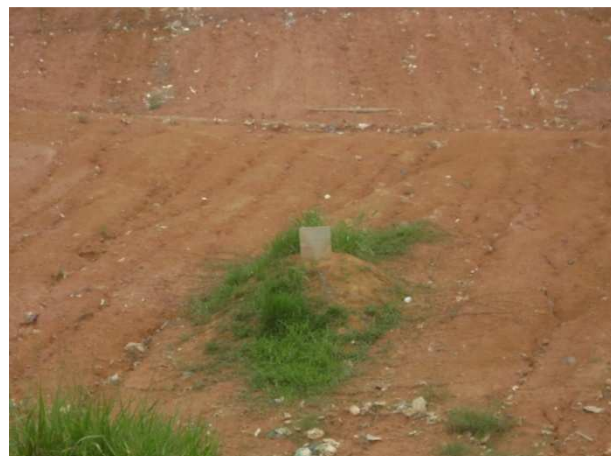
Figura 56 – Extremidade do Dreno Vertical encerrado – CTR Rio das Ostras
