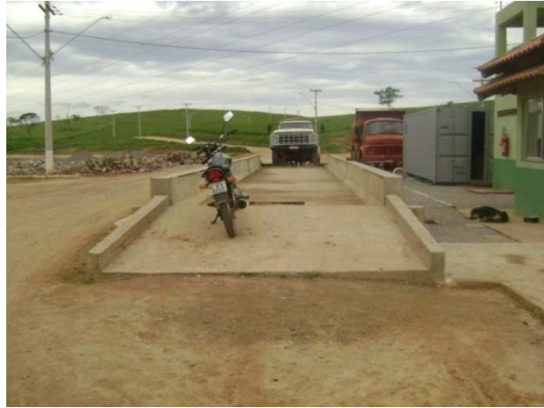
Figura 65 - Plataforma da Balança Rodoviária – CTR Macaé
