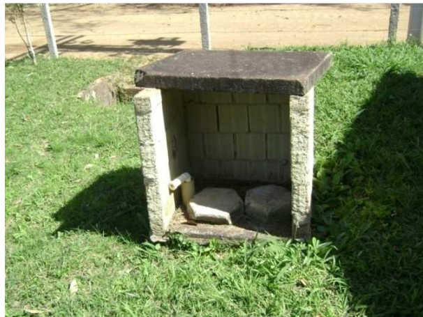
Figura 29 – Poço de Monitoramento de Águas Subterrâneas - Aterro Sanitário de Pirai
