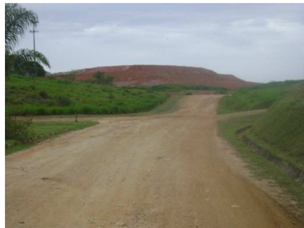
Figura 50 – Acesso a Frente de Trabalho – CTR Rio das Ostras
