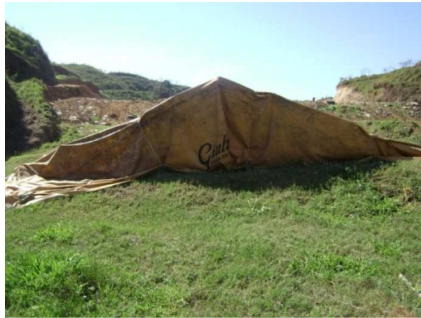
Figura 17 – Célula de Resíduos de Saúde- Aterro Sanitário de Pirai
