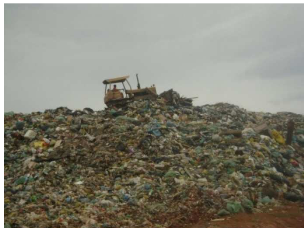
Figura 46 – Compactação dos Resíduos – CTR Rio das Ostras
