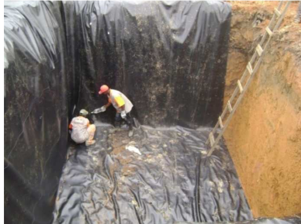
Figura 45 - Construção da Vala Séptica - CTR Rio das Ostras
