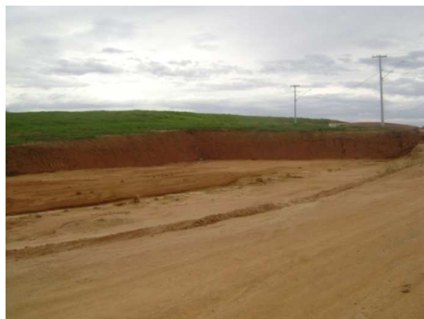
Figura 68 - Área preparada para Instalação da Autoclave
