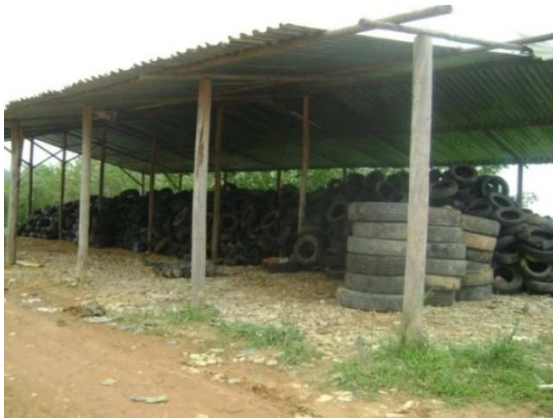
Figura 33 - Galpão para Depósito de Pneus
