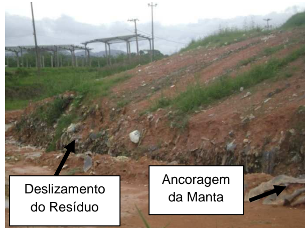
Figura 57 – Ancoragem da Manta de PVC – CTR Rio das Ostras
