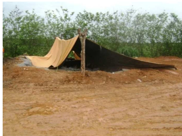
Figura 42 – Cobertura da Vala Séptica em operação – CRT Rio das Ostras
