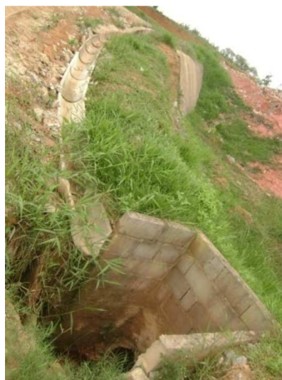
Figura 52 – Drenagem no pé do Talude – CTR Rio das Ostras
