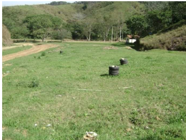
Figura 22 – Camada de Cobertura Final – Parte do Primeiro Nível do Aterro Sanitário de Pirai
