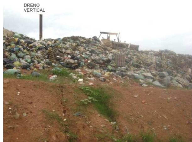
Figura 55 – Dreno Vertical na Frente de Operação – CTR Rio das Ostras
