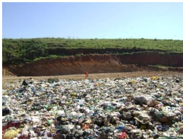
Figura 12 – Resíduos Espalhados para Nivelamento da Área – Aterro Sanitário de Pirai
