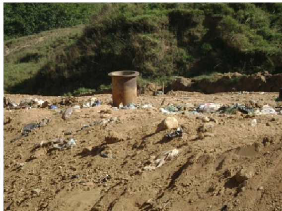
Figura 16 – Filtro Receptor do Lodo de Fossas – Aterro Sanitário de Pirai
