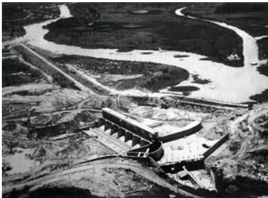
Figura 37. Barragem de captação de água bruta.
