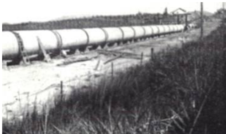
Figura 34. Linha de 1,75m sobre berços de apoio em terreno pantanoso. Fonte: Acervo da Imprensa Nacional, apud SANTA RITTA, 2009.
