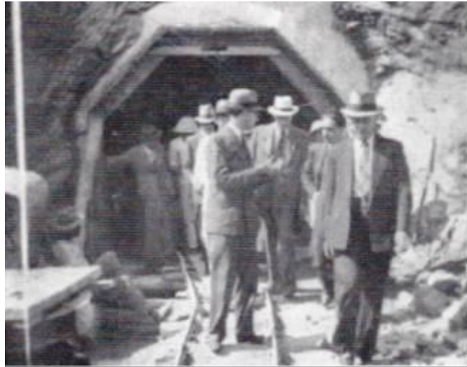
Figura 31. Flagrante as saída dos visitantes do Túnel 1, cujo comprimento é 770m. Fonte: Acervo da Imprensa Nacional, apud SANTA RITTA, 2009.
