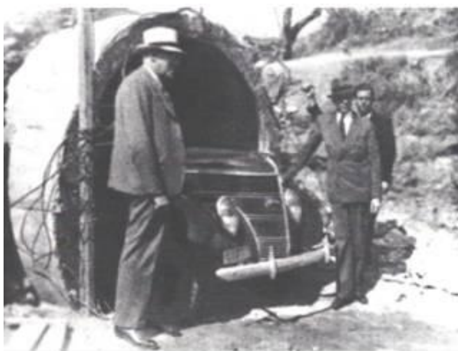
Figura 30. Tubo de baixa pressão de 1,75m de diâmetro. Fonte: Acervo da Imprensa Nacional, apud SANTA RITTA, 2009.
