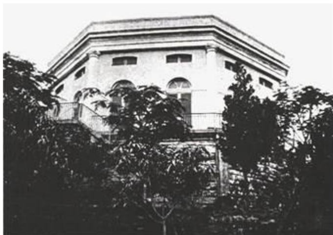
Figura 25. Reservatório da Quinta da Boa Vista.
