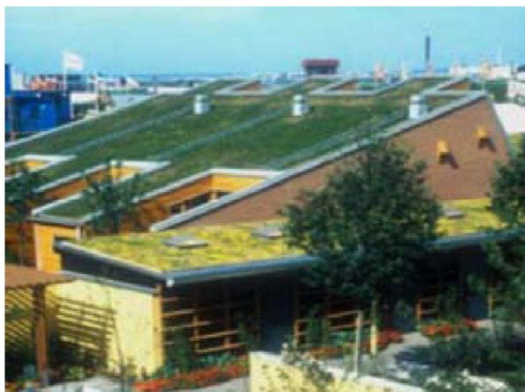
Figura 6 – Aplicação de um telhado verde extensivo com plantas de pequeno porte. Fonte: LAGSTRÖM, 2004.
