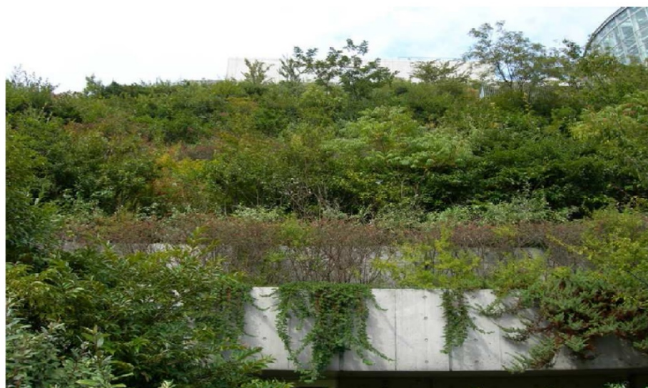
Figura 4 - Aplicação de um telhado verde intensivo, com plantas de maior porte.
