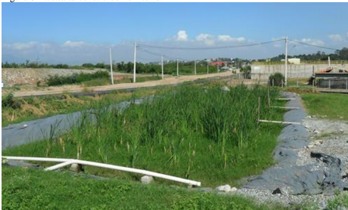
Figura 6 - Wetland construído no Aterro.
