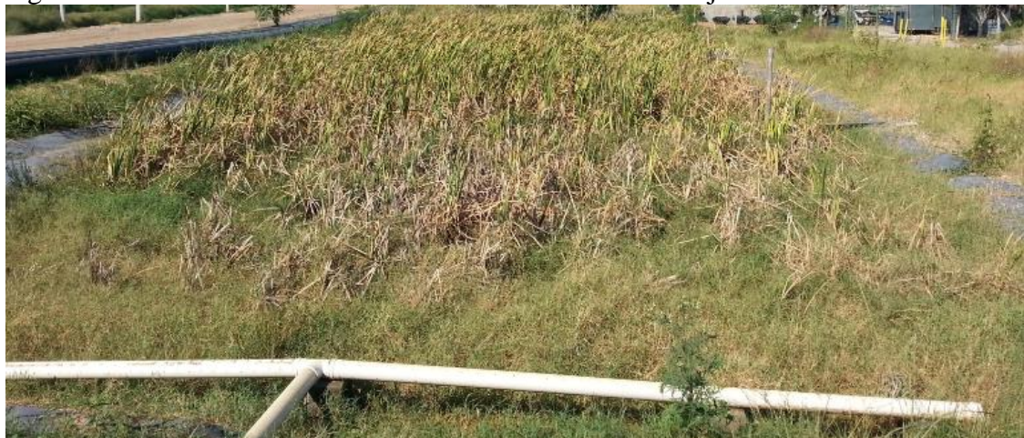
Figura 19 - Foto da zona afluente do wetland construído em janeiro de 2014.
