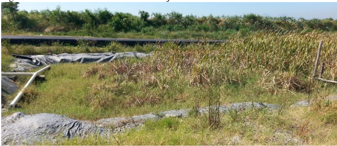
Figura 18 - Foto do wetland construído em janeiro de 2014.
