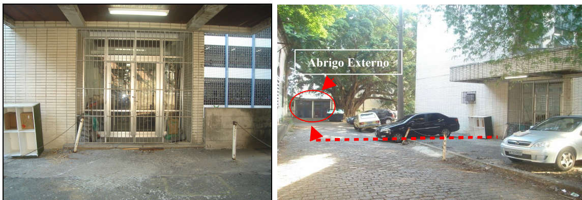
FIGURA 8 – Porta de saída dos RSS e localização do abrigo de resíduos na FOUERJ.
