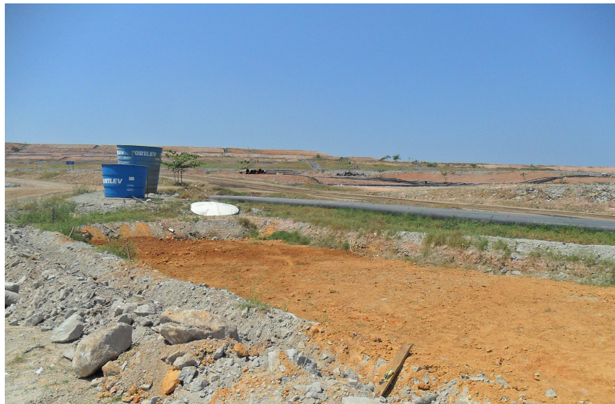
Figura 11: Nivelamento da fundação
