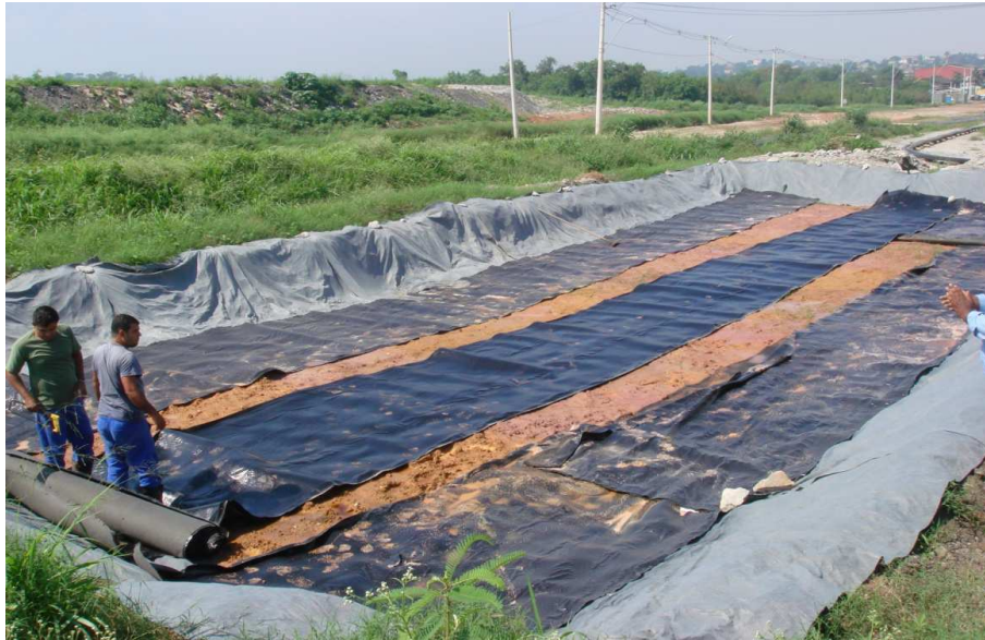
Figura 12: Instalando uma proteção para manta de PEAD
