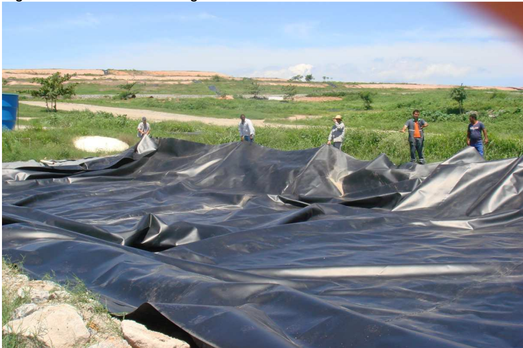
Figura 15: Posicionando a geomembrana no wetland.
