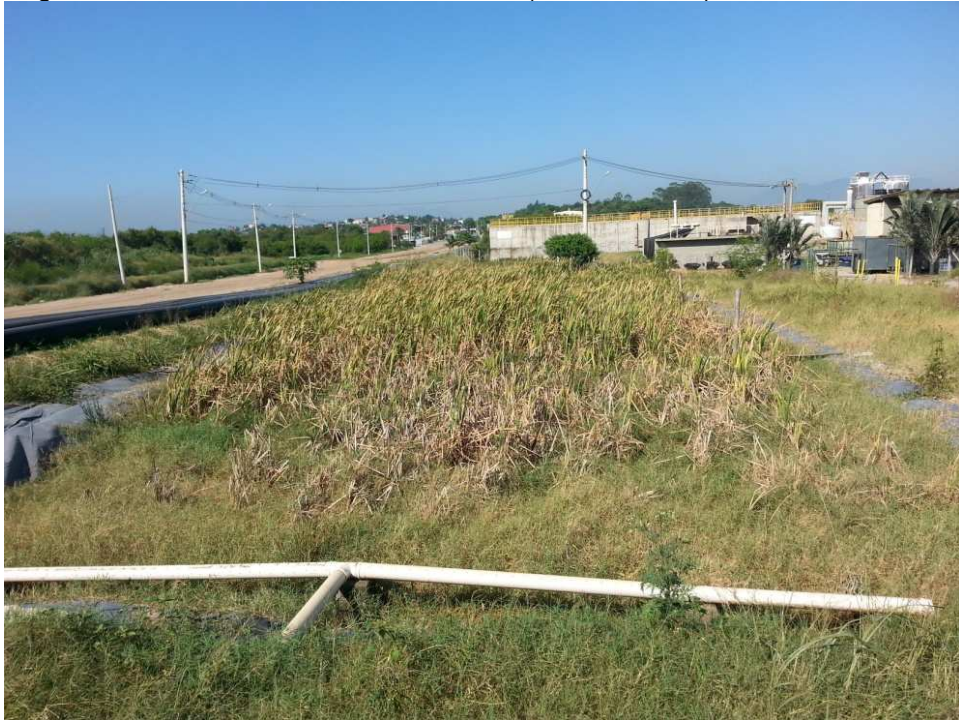
Figura 40: Vista da entrada do wetland (Janeiro 2014)
