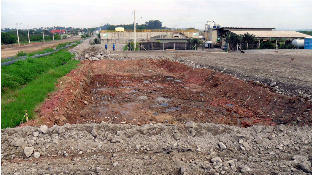
Figura 10: Vista do início da construção: escavação
