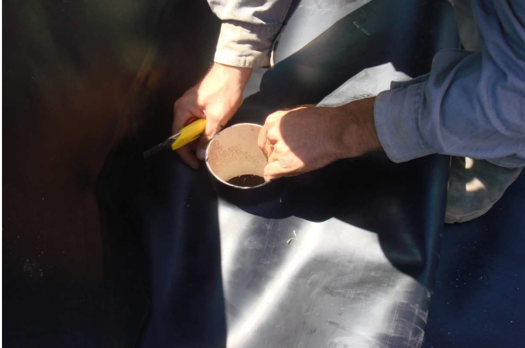
Figura 16: Detalhe da preparação para soldagem da tubulação de saída
