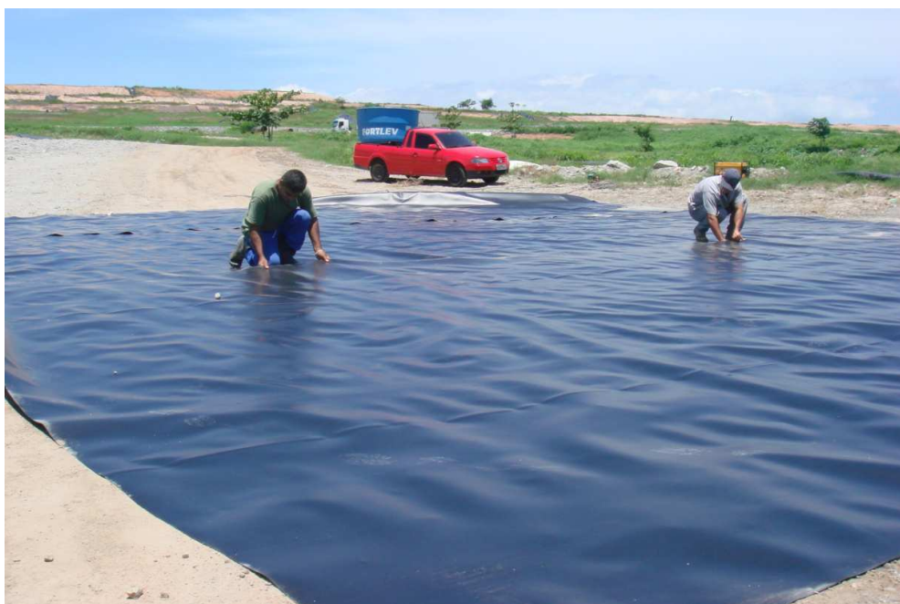
Figura 13: Posicionando a geomembrana para a soldagem
