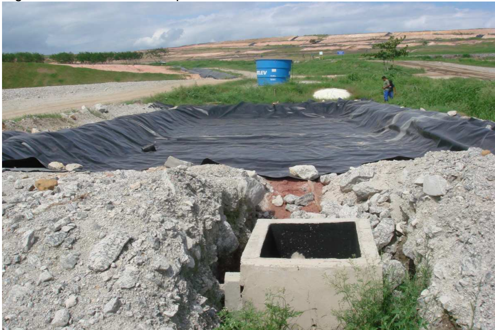
Figura 17: Vista da manta posicionada e da caixa de saída
