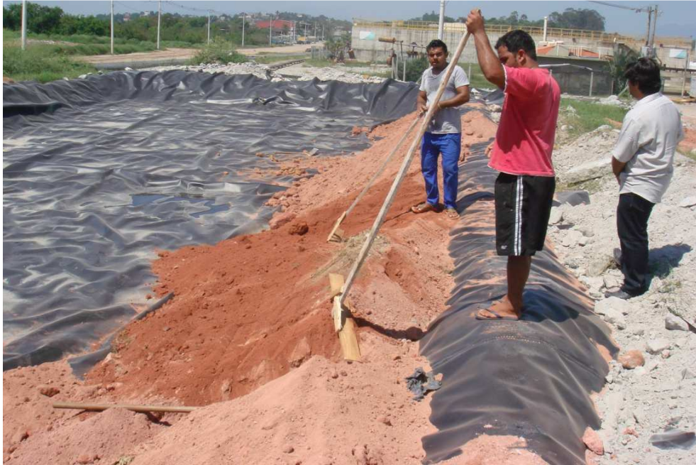
Figura 18: Lançamento da camada de argila.
