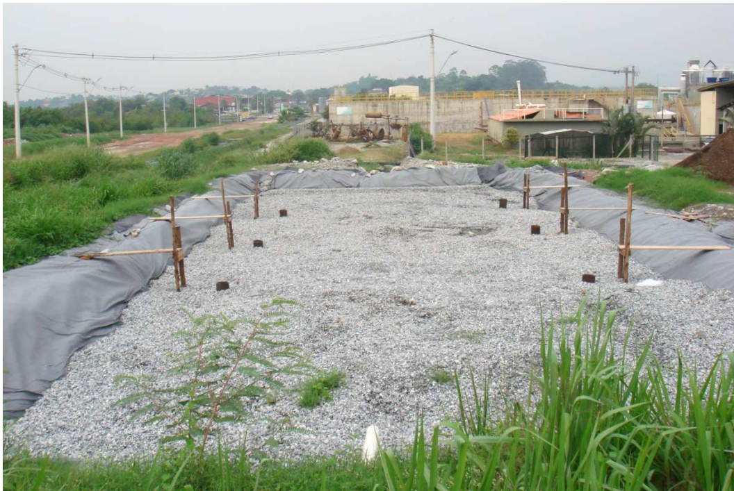
Figura 19: Vista da camada de brita e dos pontos de amostragem.
