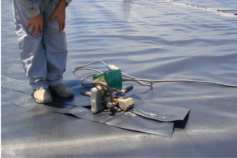
Figura 15: Posicionando a geomembrana no wetland.
