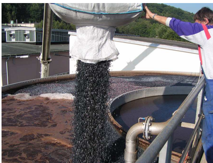
Figura 2.24. – Enchimento de um reator MBBR. Fonte: BIODOS (2013).
