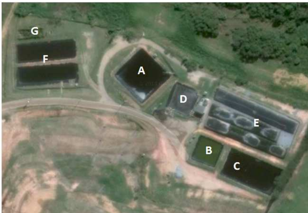
Figura 10 - Vista aérea da Estação de Tratamento de Lixiviado de Rio das Ostras.
