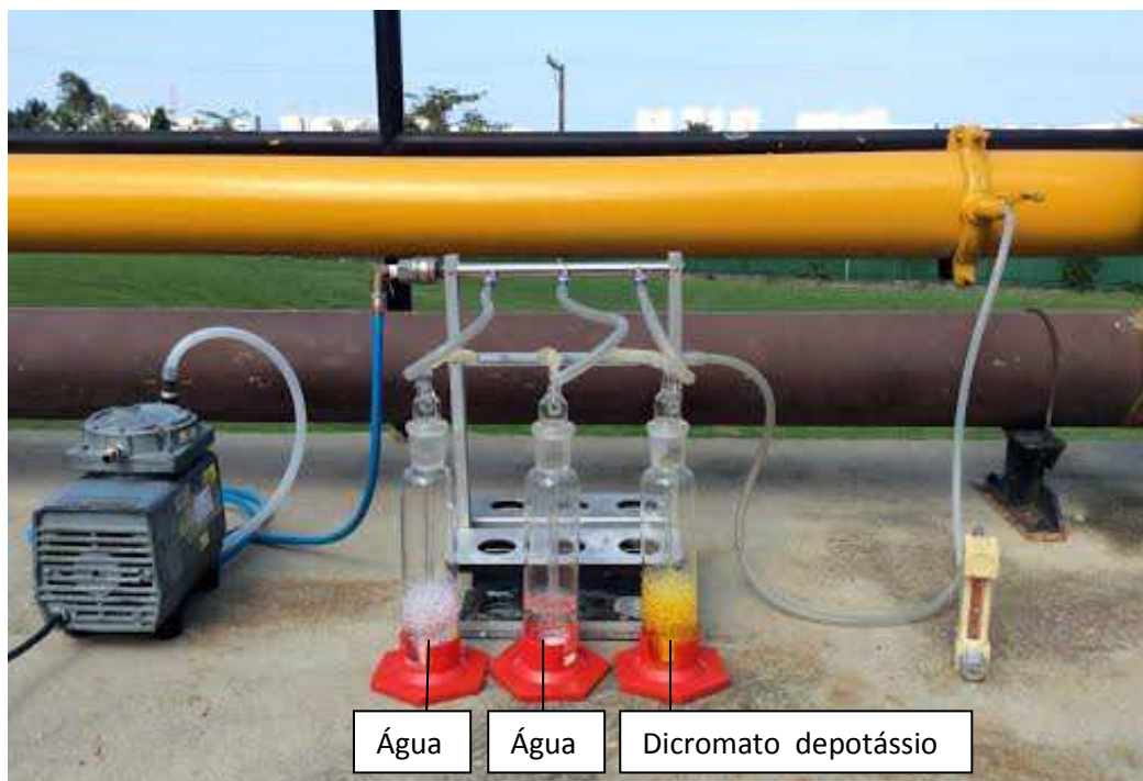
Figura 2.8 - Absorção da matéria orgânica dos gases captados na tubulação geral da ETEI.
