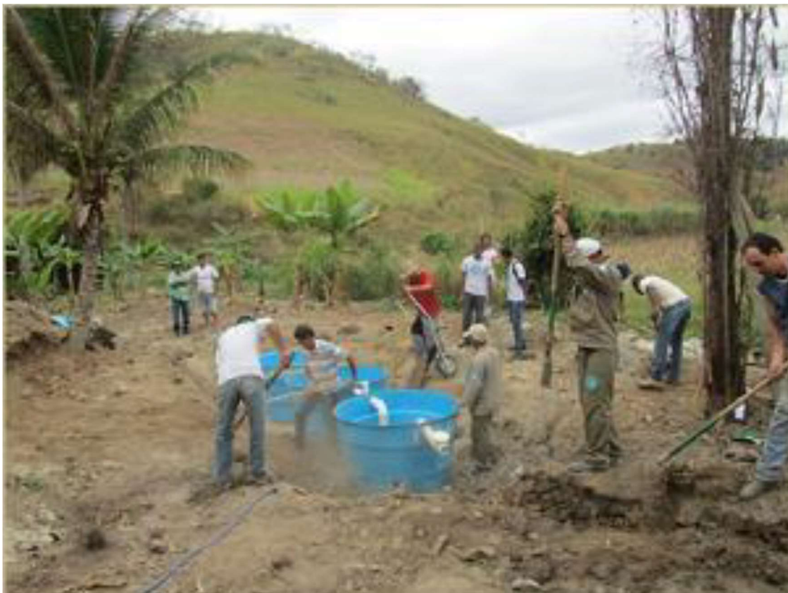
Figura 32 - Instalação da fossa séptica biodigestora. Fonte: Instituto Terra, 2015.
