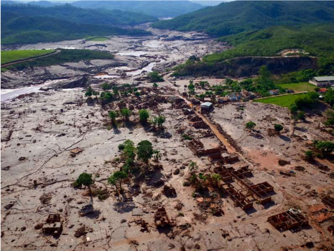
Figura 12- Distrito de Bento Rodrigues (Mariana-MG) após o rompimento da barragem. Fonte: IBAMA. Disponível em: http://www.ibama.gov.br/publicadas/onda-de-rejeitos-da-samarco-atingiu-663-km-de-rios-e-devastou-1469-hectares-de-terras . 2/12/2015.
