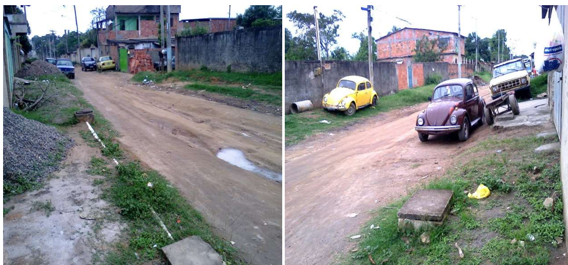
Figura 48. Sistema comunitário de evacuação de esgotos – Rua Resende da Costa
