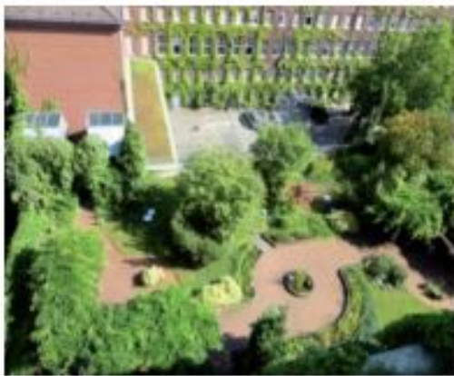
Figura 6 – Telhados verdes intensivos
