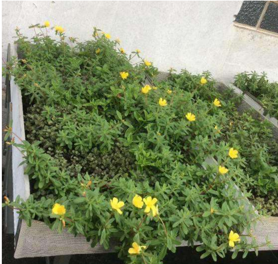
Figura 5 – Telhados verdes extensivos implantados em estruturas modulares plásticas tipo “Cidade Jardim”, planta espécie de suculentas, predominância da Portulaca oleracea (nome popular “onze horas”).
