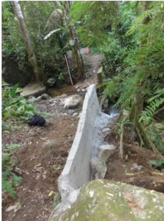
Figura 15 – Vertedouro de seção retangular instalado no Rio Sacarrão (Parque Estadual da Pedra Branca)
