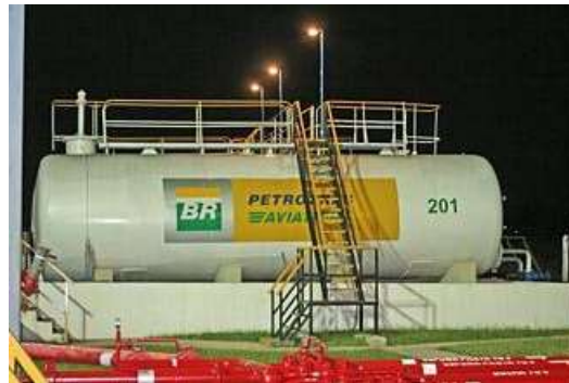
Figura 4 – Tanque horizontal construído no nível do solo
