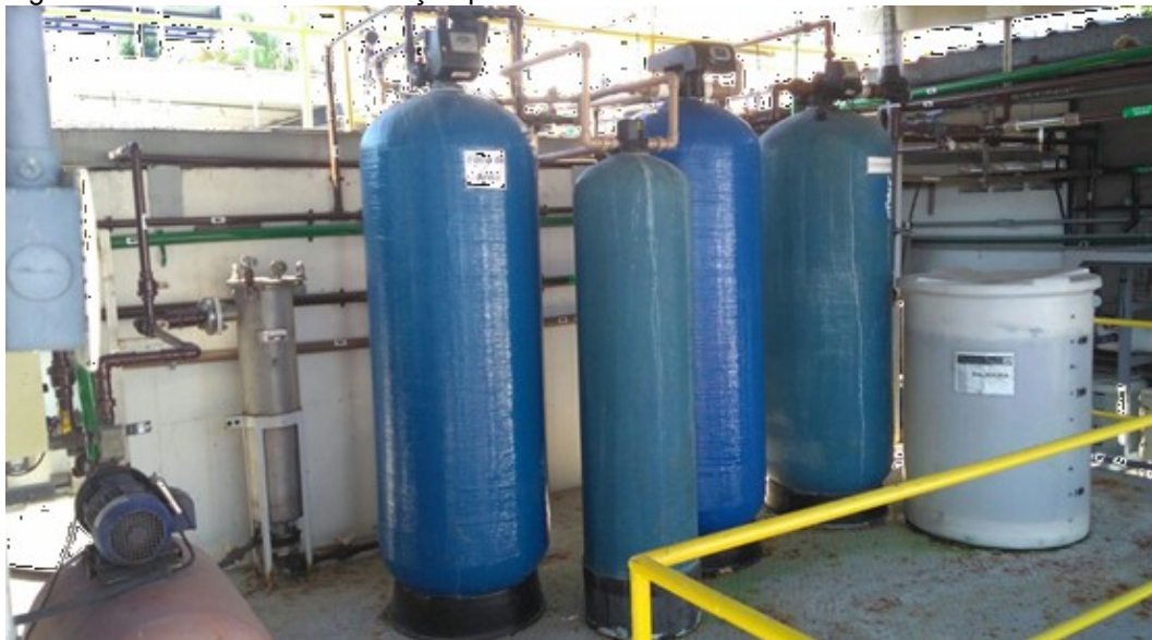
Figura 7 – Foto de sistema filtração para reuso de efluentes de indústria farmacêutica
