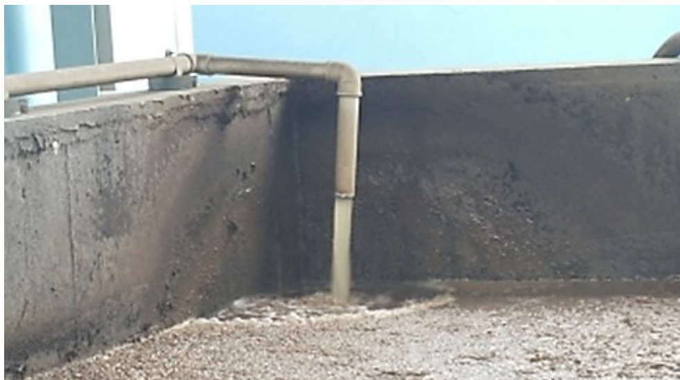
Figura 19 - Afluente sanitário e industrial
