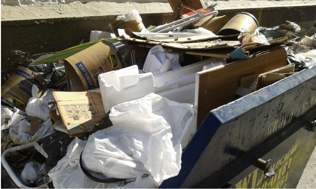
Figura 17 - Caçamba estacionária de RCC com diversos tipos de resíduos misturados.
