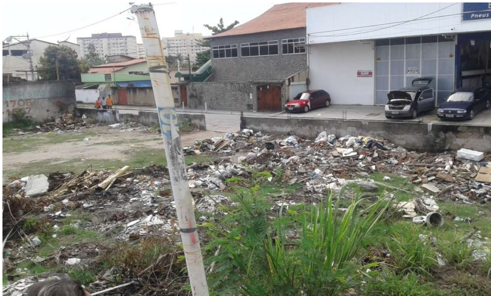
Figura 7: Deposição de RCC em terreno no bairro Colubandê.
