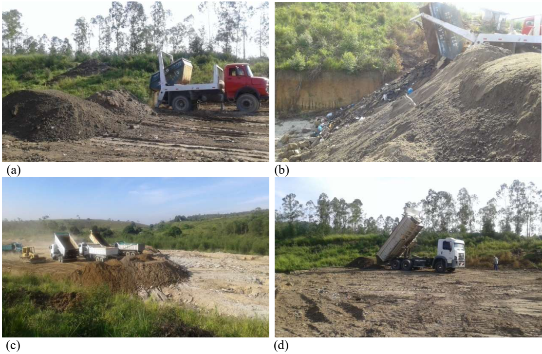
Legenda: (a) e (b) – disposição de RCC por caminhão poliguindaste; (c) e (d) – disposição de RCC por caminhões basculantes. Fonte: Autor, 2016.
