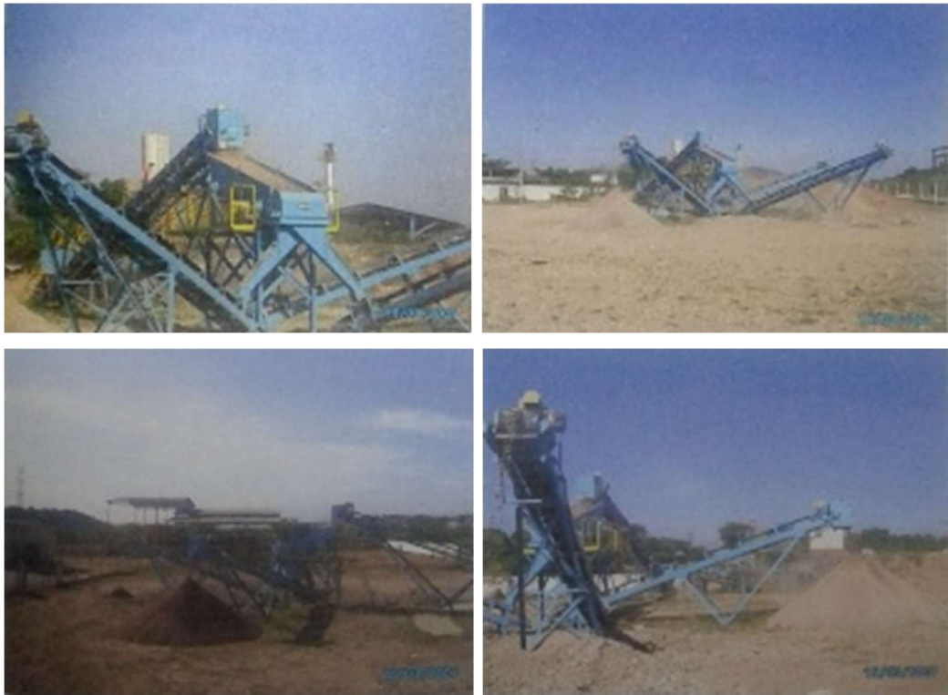
Figura 13 - Unidade de beneficiamento de entulhos de obras no Aterro de Itaóca.
