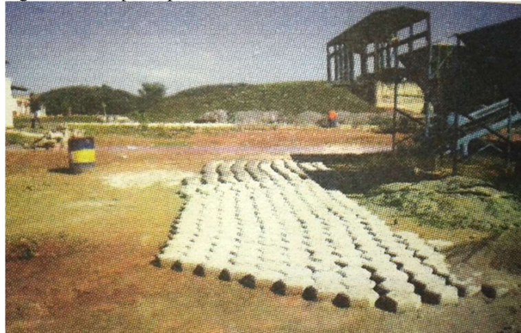
Figura 14 - Bloquetes produzidos na unidade de beneficiamento de entulhos de obra.
