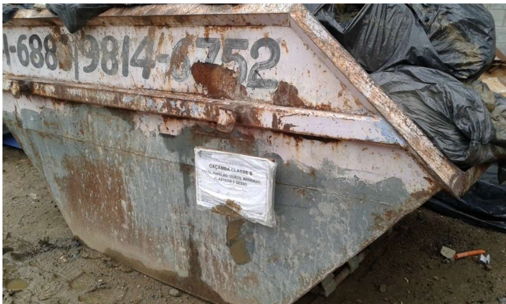
Figura 31 - Caçamba destinada à coleta de RCC classe B em um canteiro de obras.
