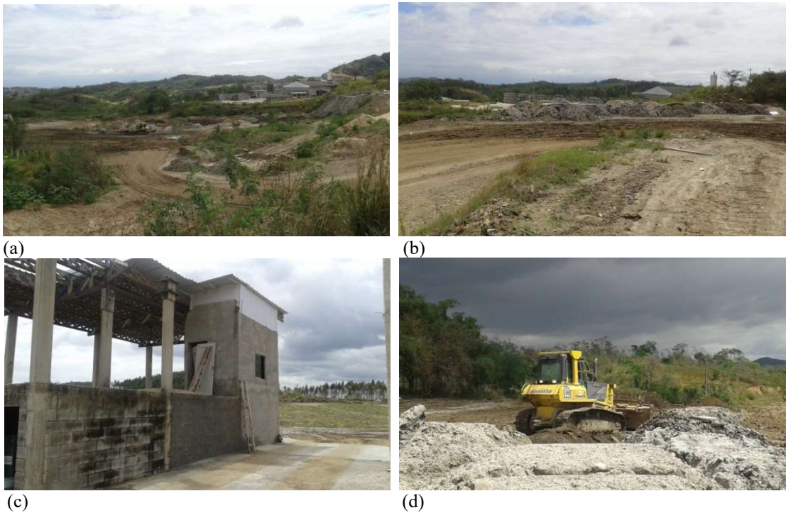
Legenda: (a) e (b) – vista geral da área da empresa; (c) – guarita e local da balança de pesagem, em construção; (d) – retroescavadeira responsável pelo espalhamento dos RCC. Fonte: Autor, 2016.
