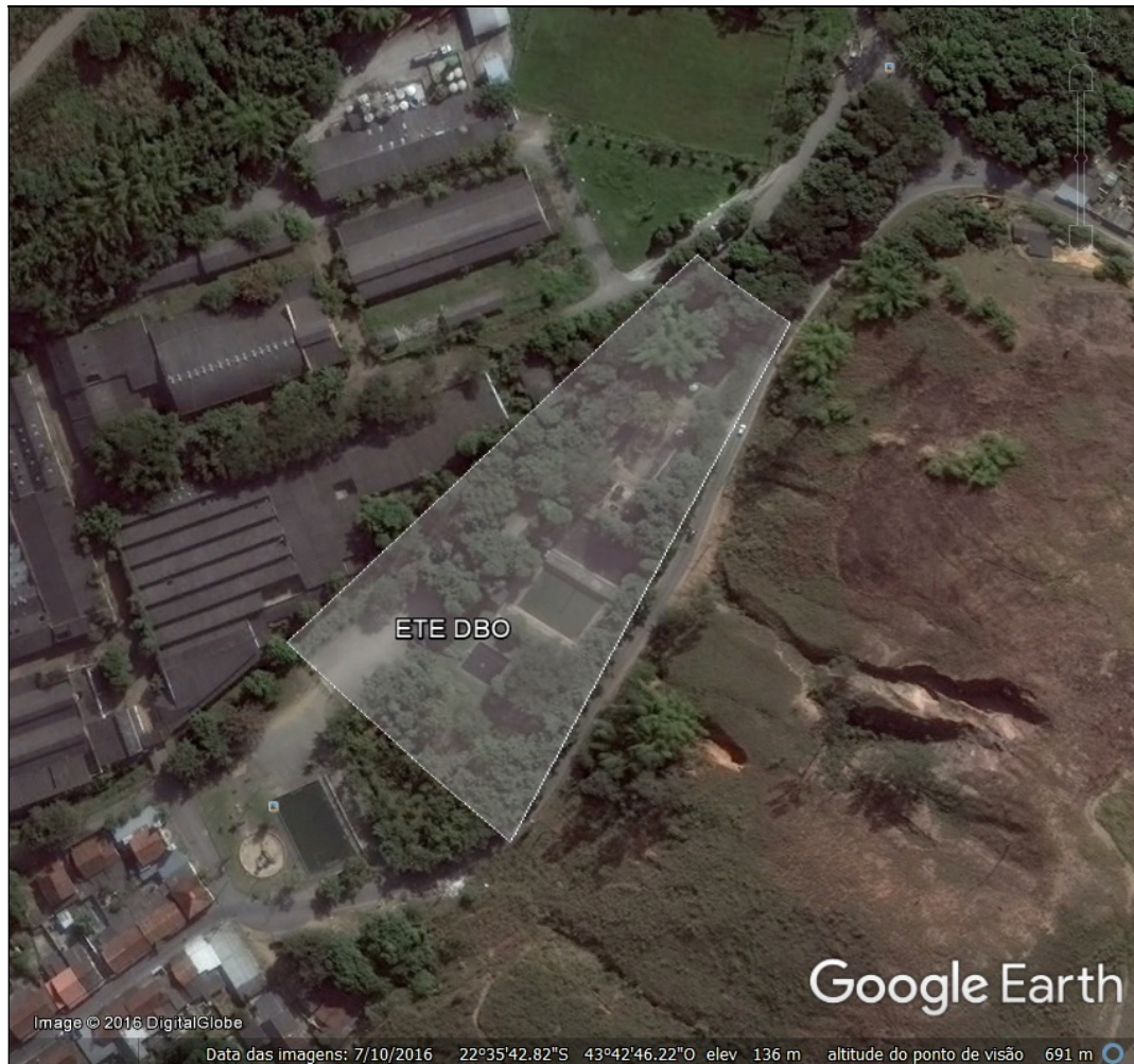
Figura 3-1 – Estação de tratamento de esgoto DBO localizada em Paracambi
