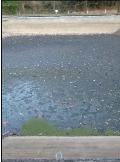
Figura 3-27 – Descarte no tanque de aeração desativado
