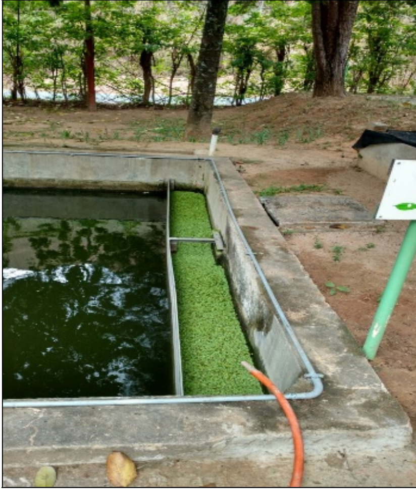
Figura 3-24 – Descarte na canaleta do decantador
