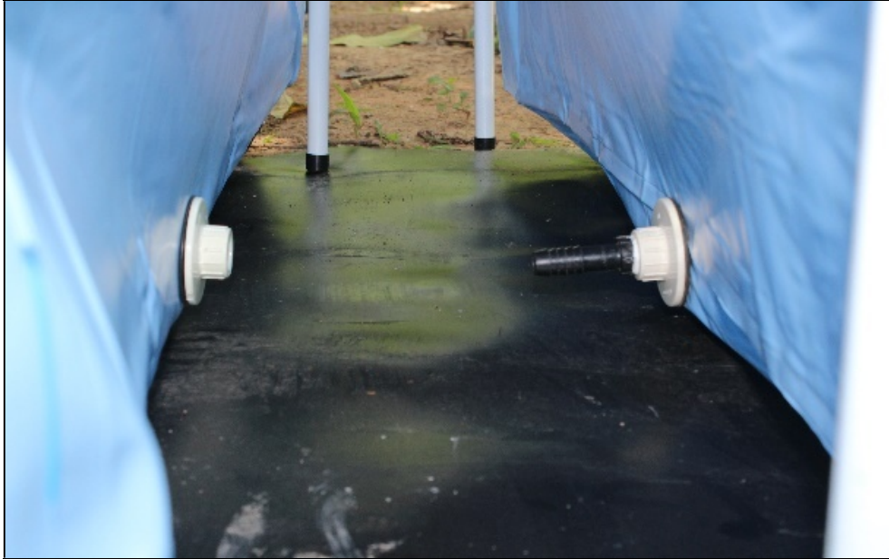
Figura 3-5 - Flanges e bico de mangueira para ligar as piscinas
