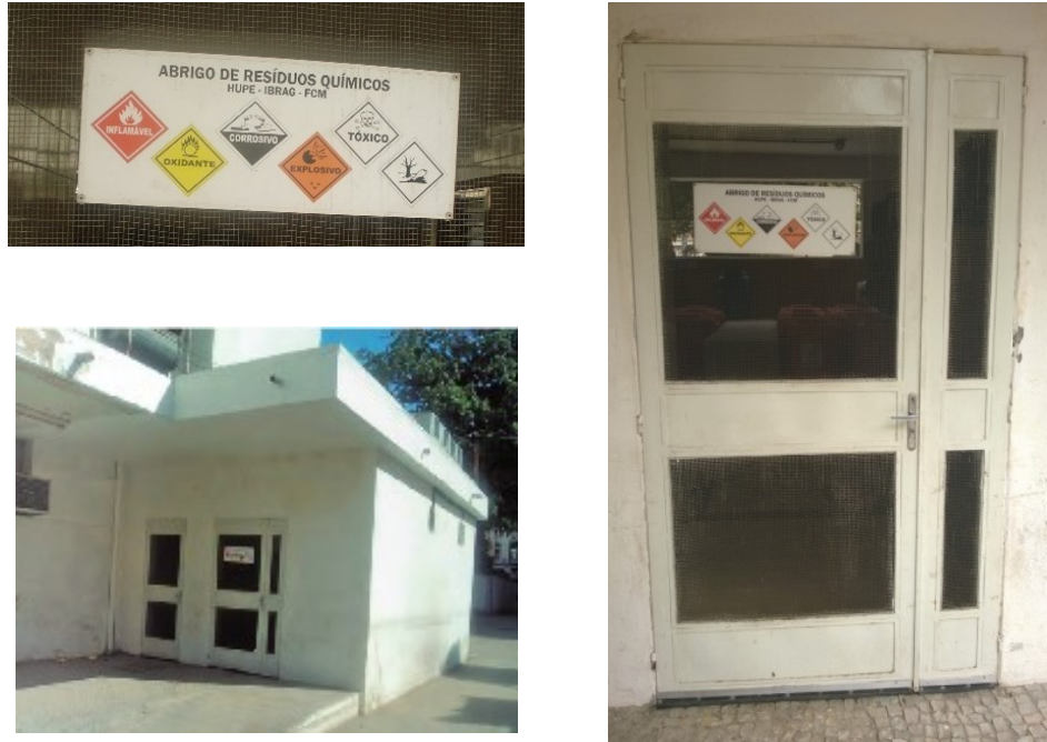
Figura 10 - Abrigo de resíduos químicos
