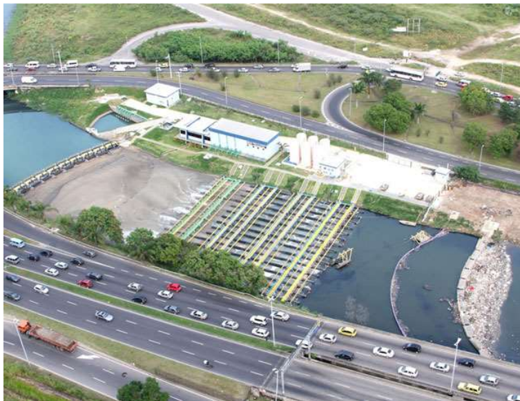
Figura 4 – Unidade de Tratamento de Rios Arroio Fundo.
