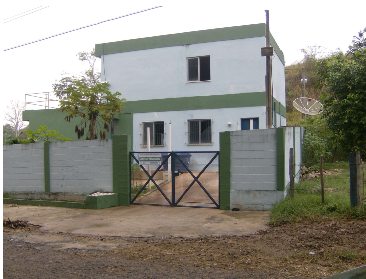
Figura 19 - ETA Campelo em Miracema gerenciada pela Águas de Pádua (14/06/2017 - 07: 47)
