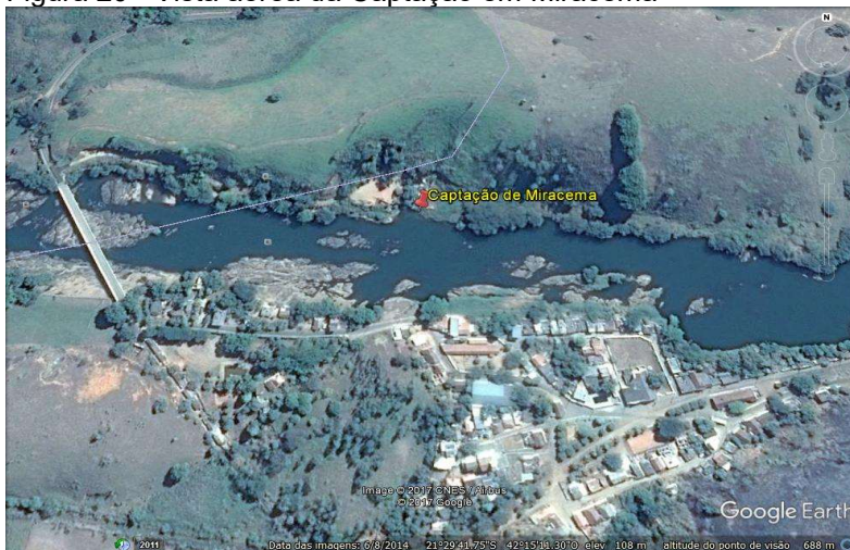
Figura 20 - Vista aérea da Captação em Miracema
