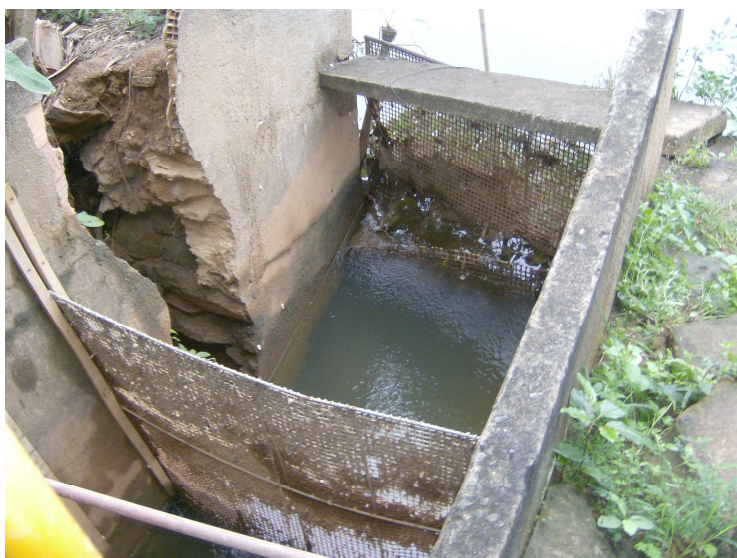
Figura 16 - Ponto de Captação Santo Antônio de Pádua (14/06/2017 – 10:44)
