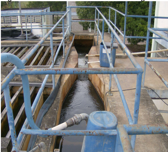
Figura 26 – ETA Miracema entrada de água no vertedor
