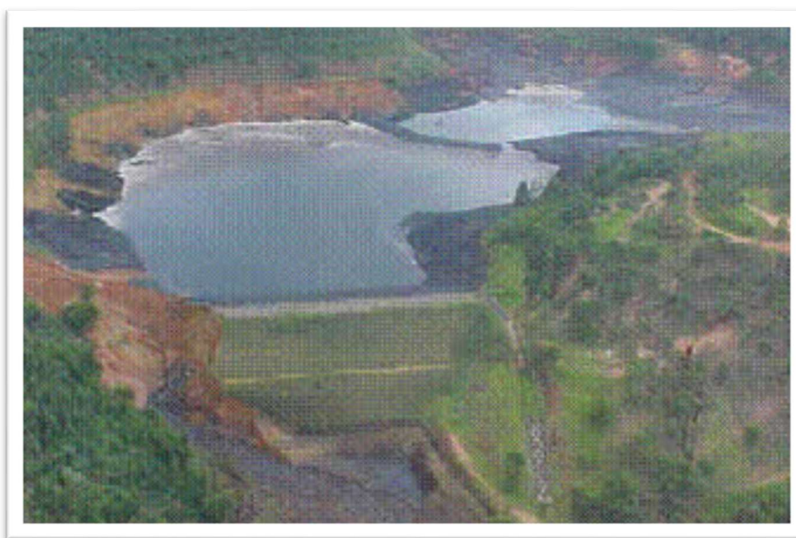
Figura 42 – Vista aérea do rompimento a barragem
