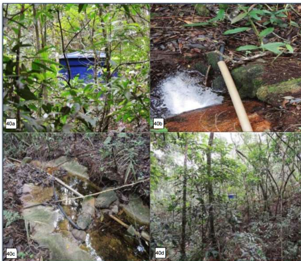
Figura 40 - Captação e armazenamento de água clandestinos na subida da Pedra Bonita (PARNA-Tijuca). 40a- caixa-d'água em meio à mata, indicando armazenamento clandestino de água; 40b- encanamentos em meio à mata, indicando captação clandestina; 40c- sistemas de encanamentos de captação de água diretamente na nascente; 40d- caixa-d'água em meio à mata, indicando armazenamento clandestino de água.
