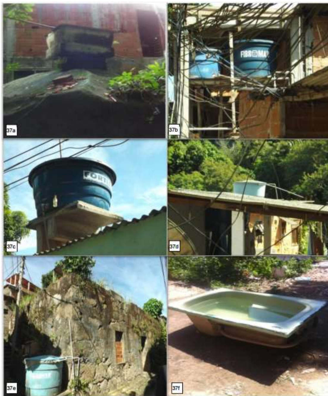
Figura 36- Armazenamento da água. 37a- caixa-d'água sobre a rocha; 37b- caixa-d'água na laje; 37c- caixa-d'água sobre a casa; 37d- caixa-d'água sobre a casa; 37e- caixa-d'água junto ao solo, próxima a parede de uma construção que é considerada uma antiga senzala; 37f- banheira reutilizada para armazenar água.
