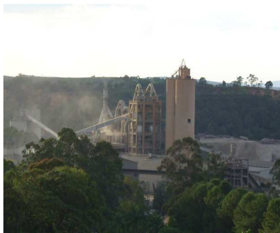
Figura 4: Emissões visíveis de material particulado.
