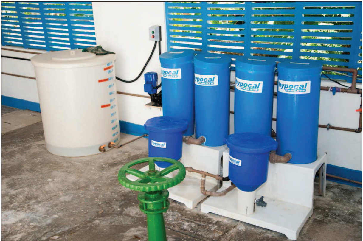
Figura 9 - Sistema de desinfecção por pastilhas de Hipoclorito de Cálcio
