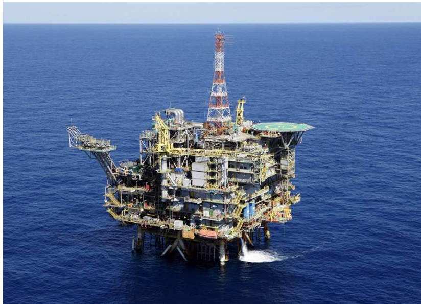
Figura 3 - Plataforma fixa de Mexilhão, na Bacia de Santos
