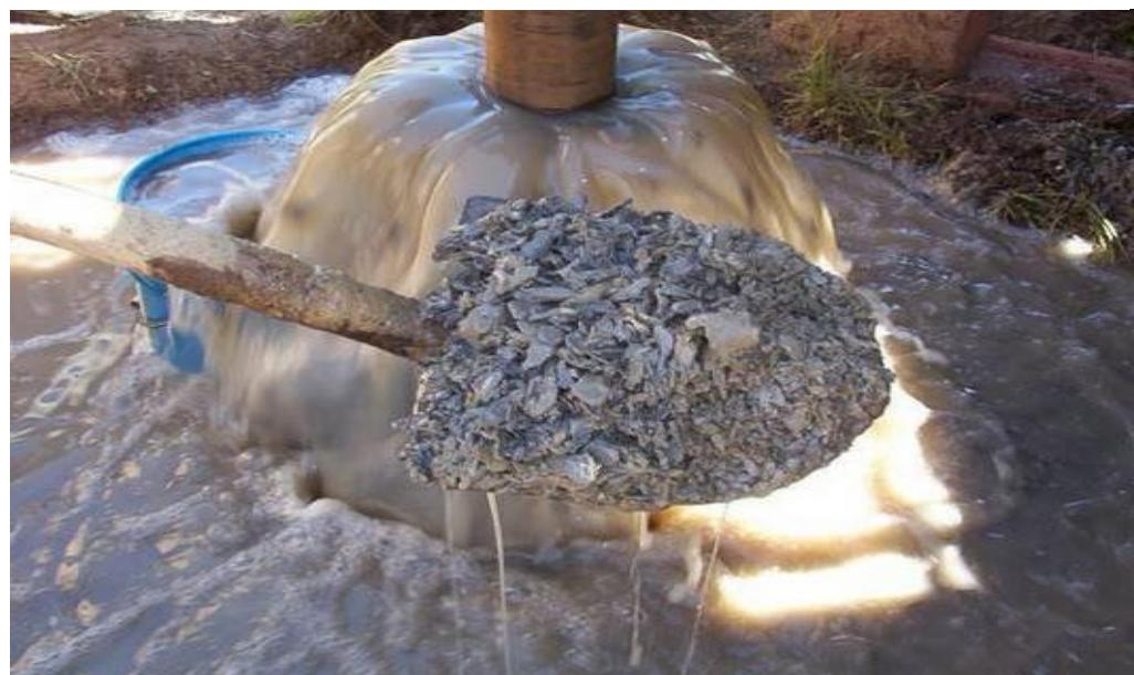
Fonte: Cascalhos removidos do fundo de um poço através do fluido de perfuração 2018.
