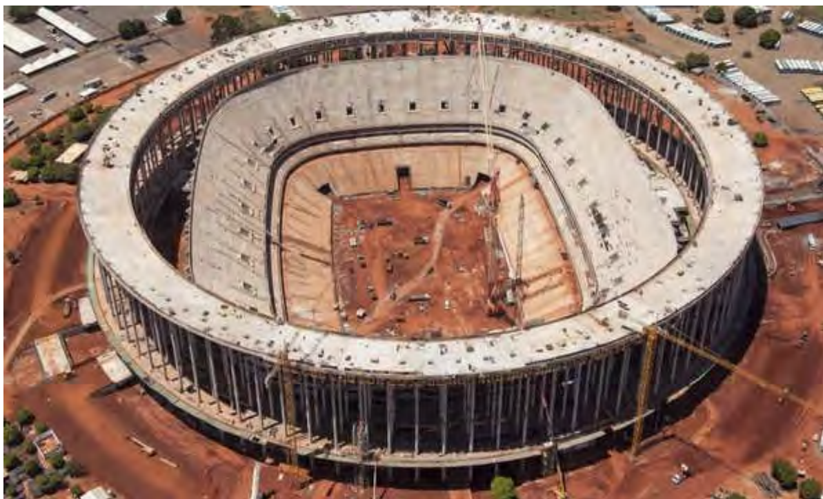
Figura 95 - Vista externa do estádio durante a construção (LIMA, 2013)
