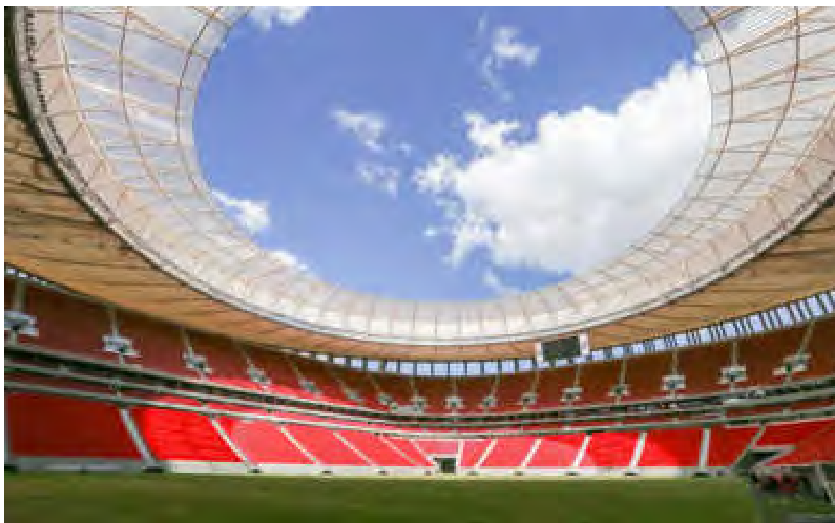
Figura 99 - Vista interna de parte da arquibancada após a reconstrução (CASTRO MELLO ARQUITETOS, 2014)
