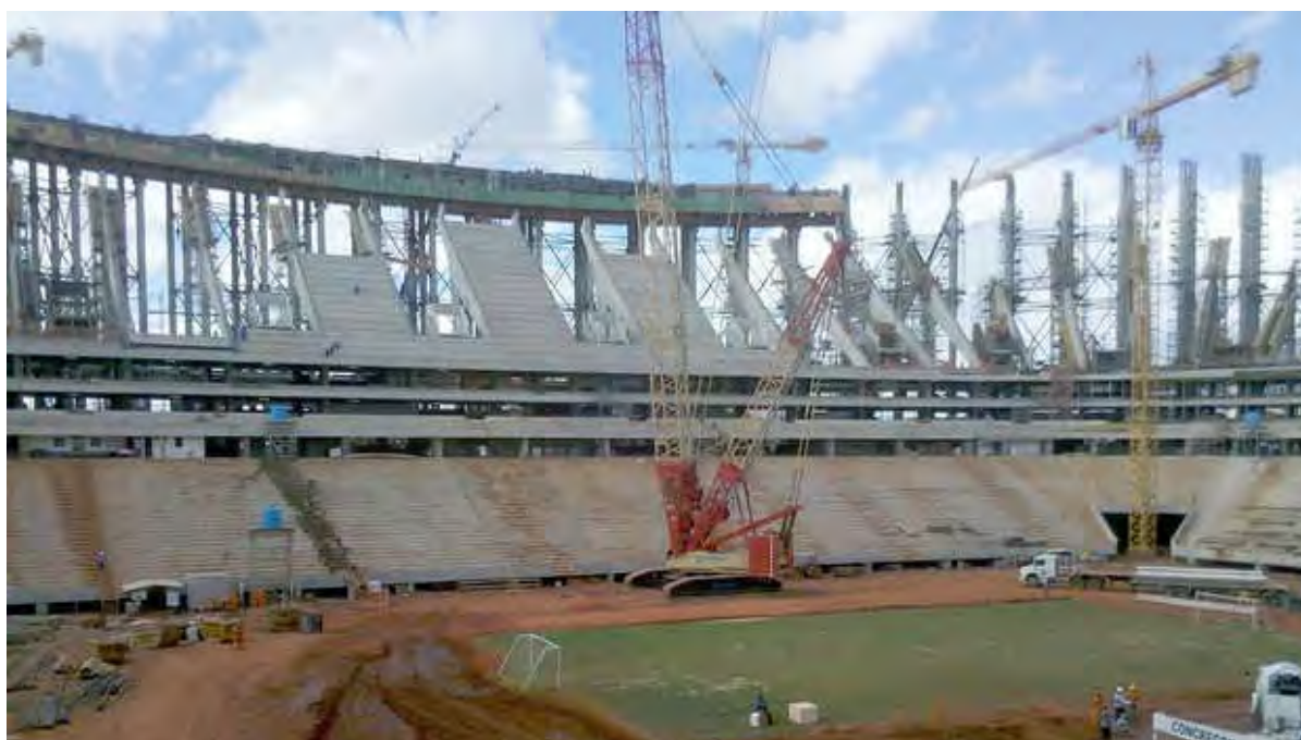
Figura 94 - Vista interna do estádio durante a construção (LIMA, 2013)
