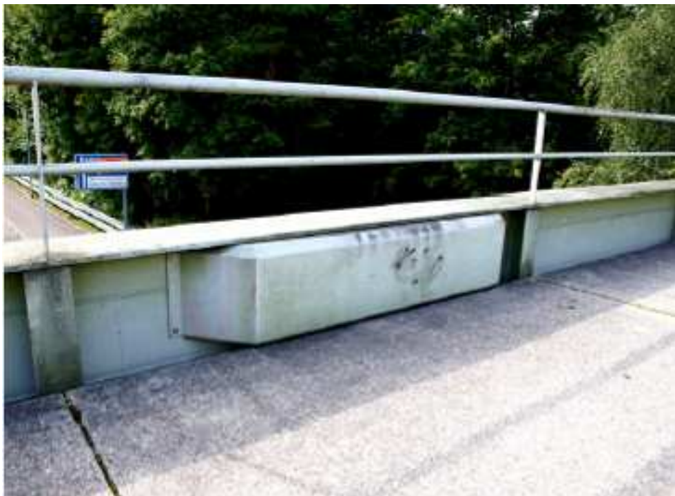
Figura 22 – Proteção do amortecedor de massa instalado na passarela com sistema estrutural em viga (Suíça) [29].
