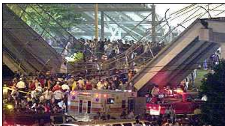
Figura 1 – Desabamento de uma passarela na Carolina do Norte/EUA [1].
