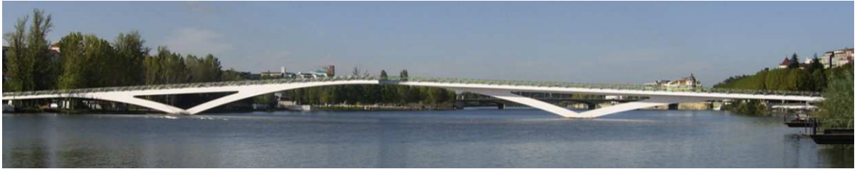
Figura 8 – Vista geral da passarela Pedro e Inês [10].
