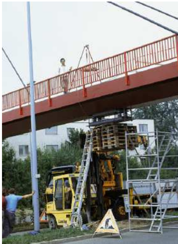
Figura 24 – Amortecedor sendo instalado na passarela com sistema estrutural em cabo estaiado (Suíça) [29].
