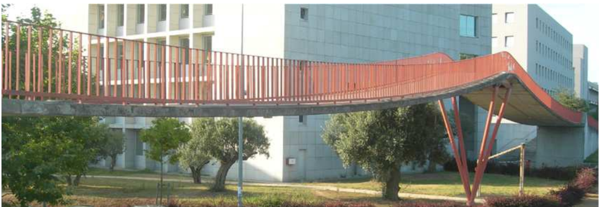
Figura 30 – Foto da passarela estudada por Hu, Caetano e Cunha [49].
