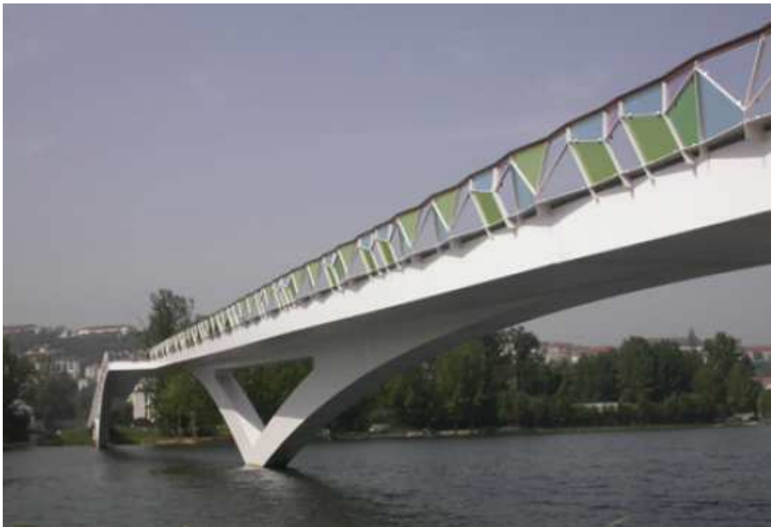
Figura 10 – Vista lateral da passarela Pedro e Inês [10].
