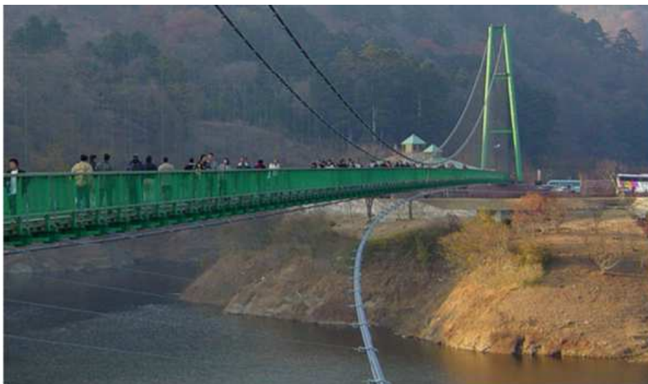
Figura 19 – Passarela real “Maple Valley” (Japão) [23].
