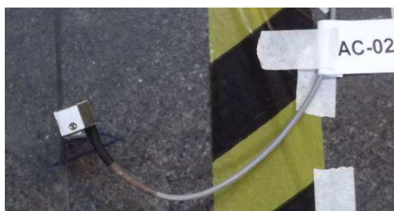
Figura 179 – Acelerômetro AC-02 localizado no Ponto 2.
