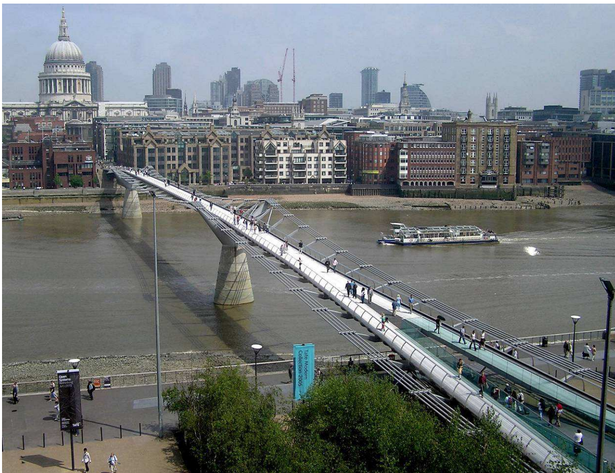
Figura 4 – Millennium Footbridge localizada em Londres sobre o Rio Tâmisia [4].
