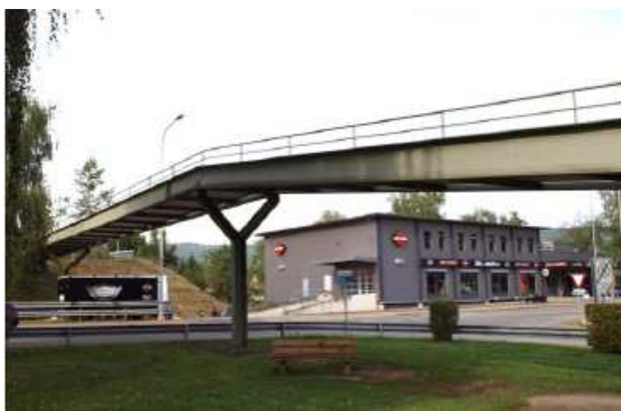
Figura 20 – Passarela real com sistema estrutural em viga estudada por Weber e Feltrin (Suíça) [29].
