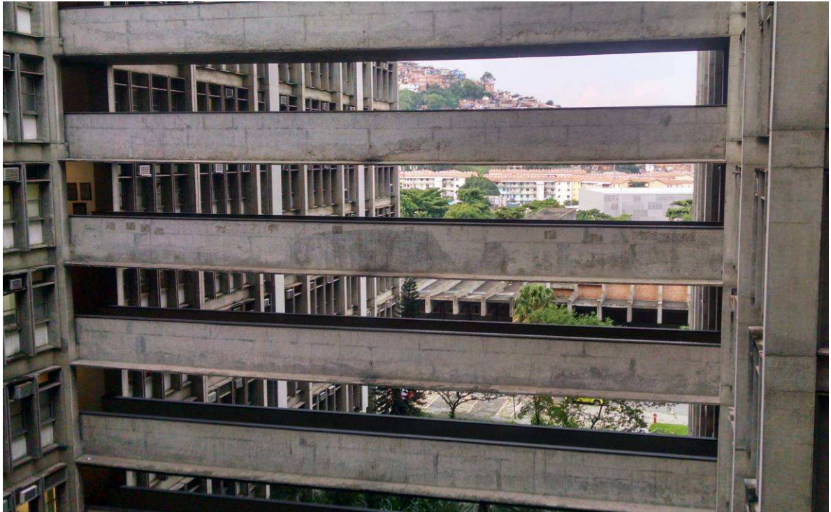
Figura 47 – Vista lateral da passarela.
