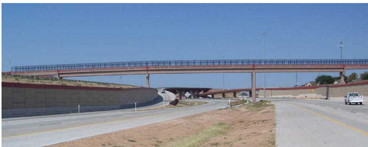
Figura 29 – Passarela simplesmente apoiada [39].
