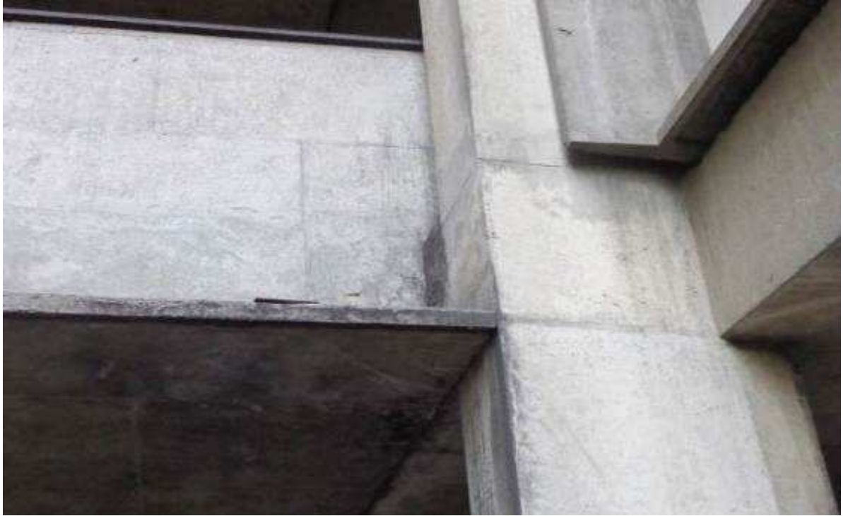
Figura 51 – Vista do apoio junto à estrutura do prédio.
