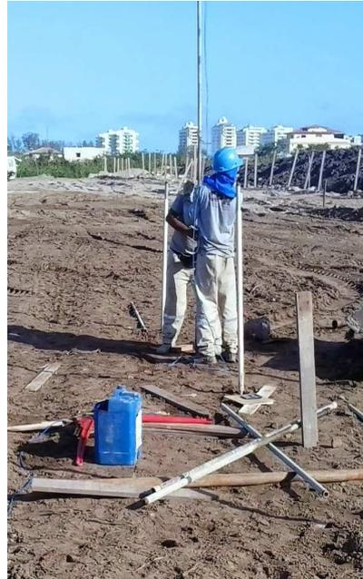
(b) Inserção do piezômetro no tubo
