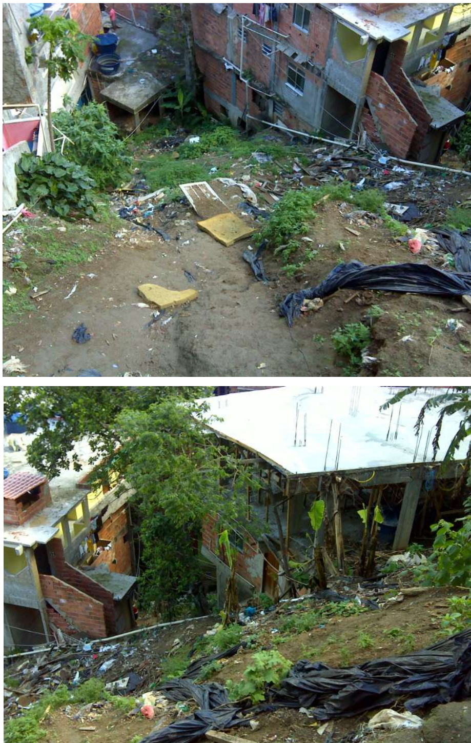
Figura 108. Lançamento de lixo e entulho
