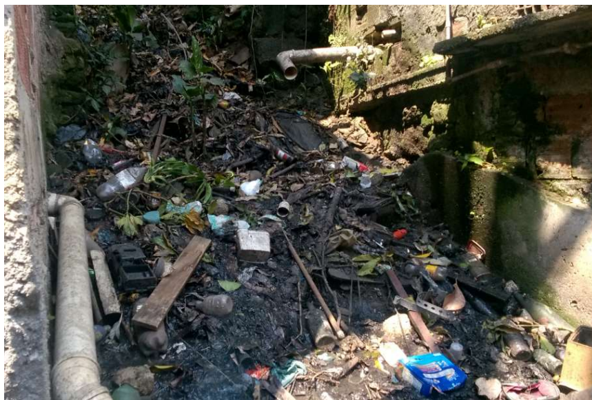
Figura 93- Lixo e detritos em geral e lançamento de efluentes no solo in natura
