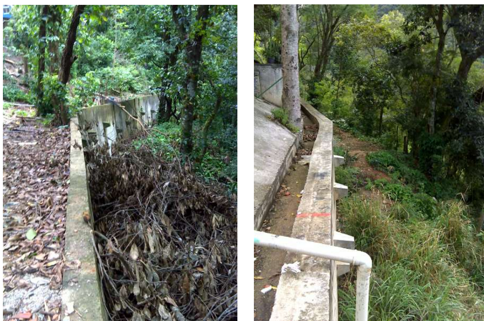
Figura 104- obra de contenção em cortina ancorada
