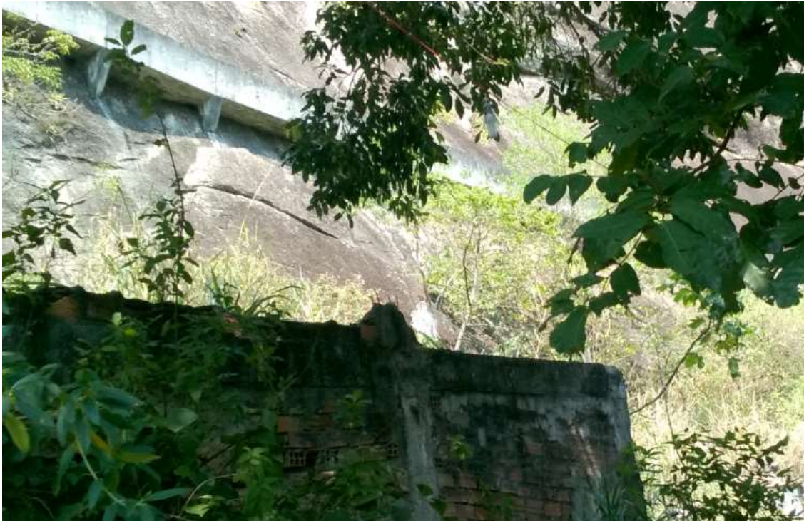
Figura 90 – Canaleta pluvial chumbada na rocha
