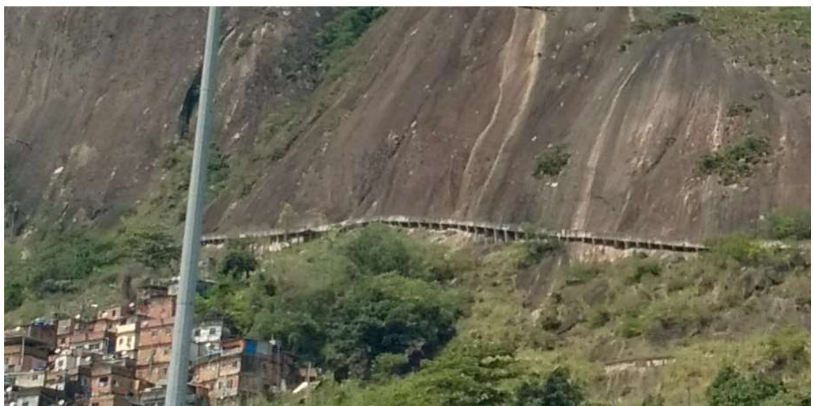
Figura 97. Detalhe da canaleta na base da escarpa
