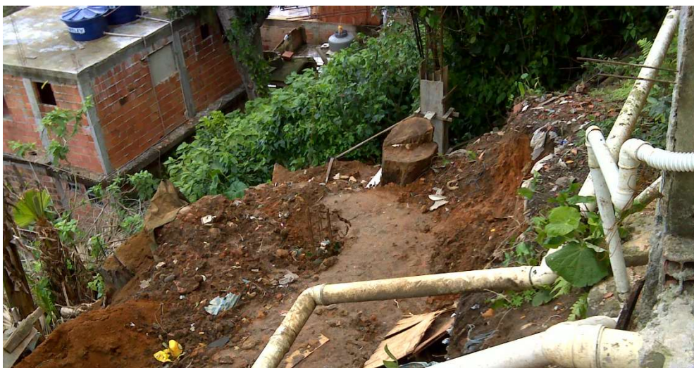
Figura 103- Lançamento de aterro in natura
