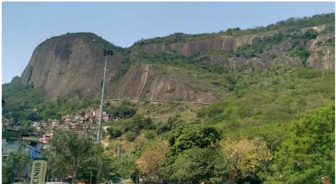
Figura 96- Vista geral da escarpa rochosa
