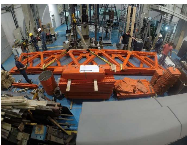
Figura 182 – Passo 01: içamento das linhas de treliça
