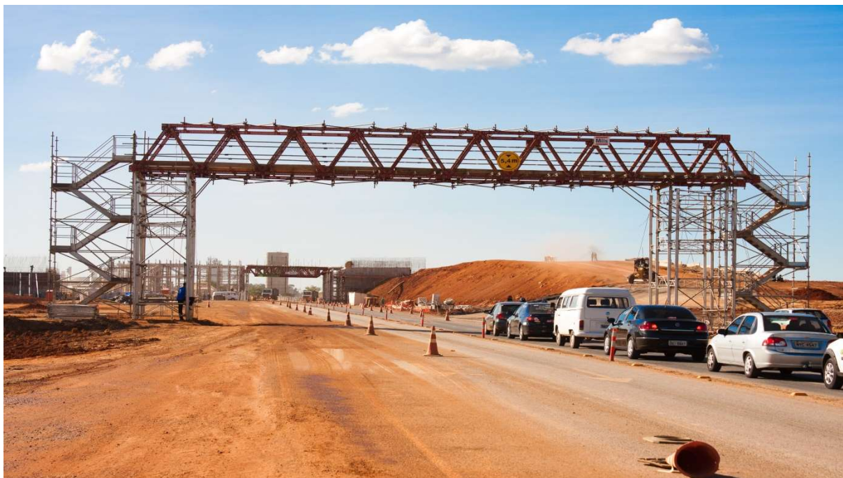
Figura 1 – Passarela SM Mills – Aeroporto de Confins – MG
