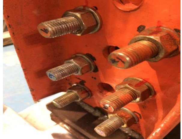
Figura 35 – Marcação de torque
