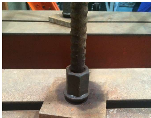
Figura 189 – Colocação das placas e porcas do tirante Dywidag
