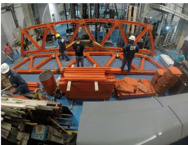
Figura 183 – Passo 02: içamento das linhas de treliça
