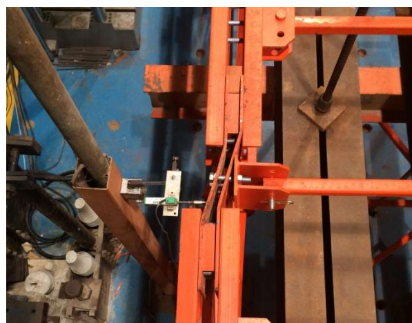
Figura 145 – Ensaio 02: detalhe do modo de ruína
