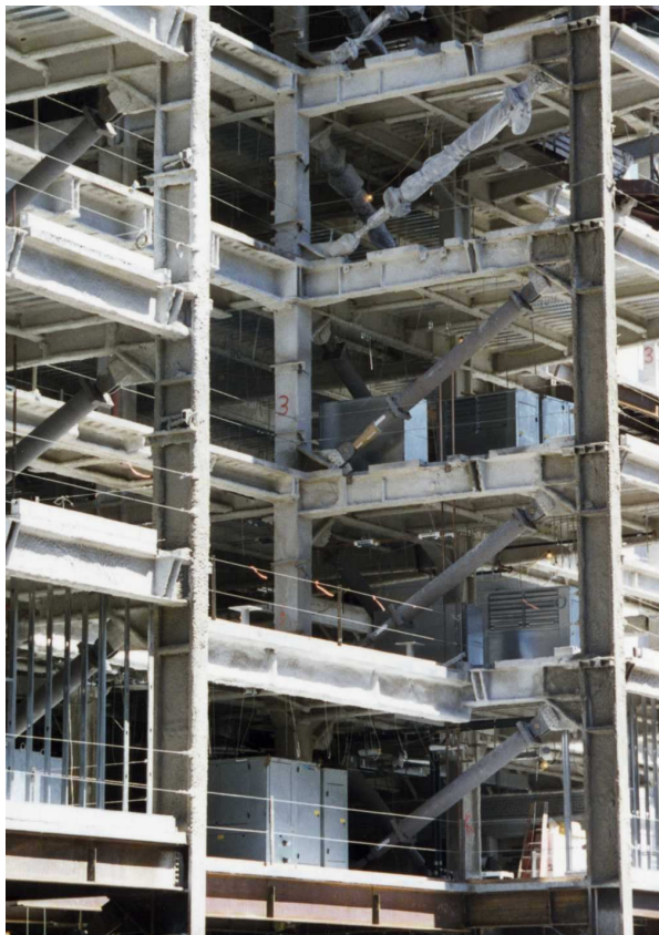
a) Perspectiva do edifício em construção
