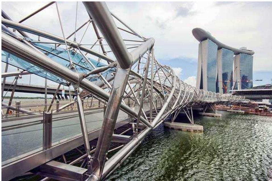
Figura 1 - Passarela em Cingapura em perfil tubular de aço inoxidável [1]
