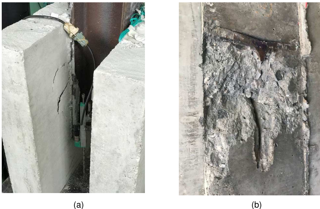
Figura 131 – Fissuras na laje e ruptura do conector TP60F
