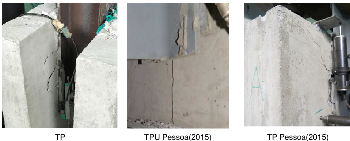
Figura 119 – Fissuração da laje
