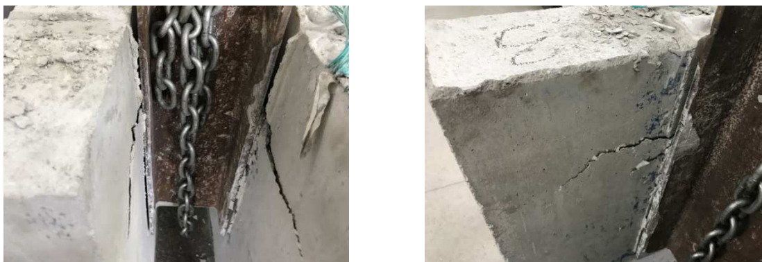
Figura 107 – Ruptura da laje – ensaios TP60
