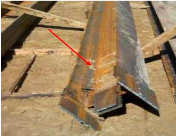
(c) Talas metálicas soldadas
