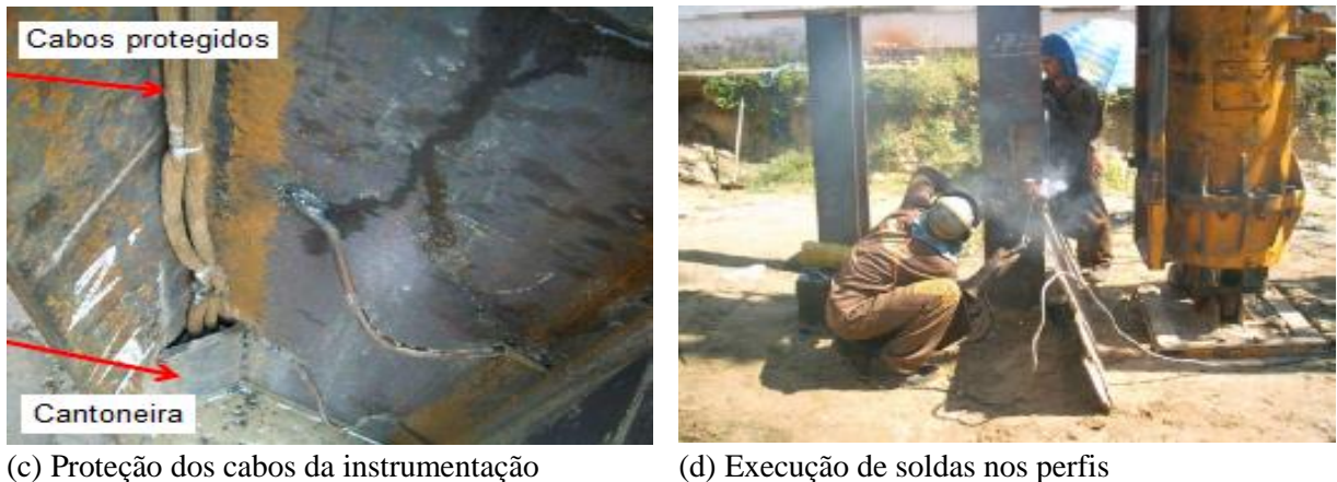
Figura 51 – Cravação das estacas e emendas dos perfis
