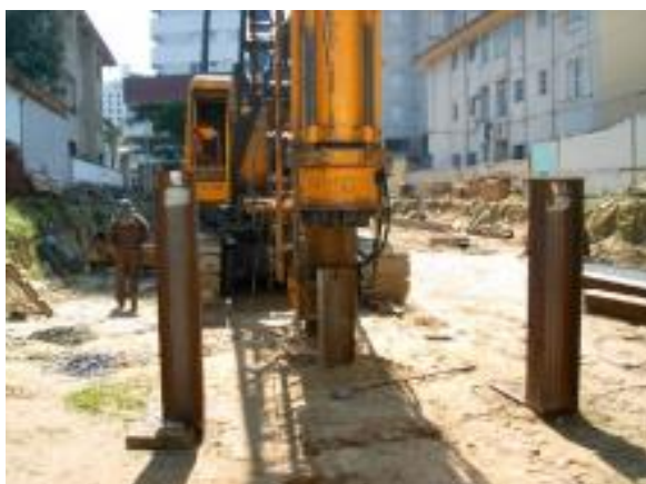
(a) Equipamento bate-estacas de esteiras
