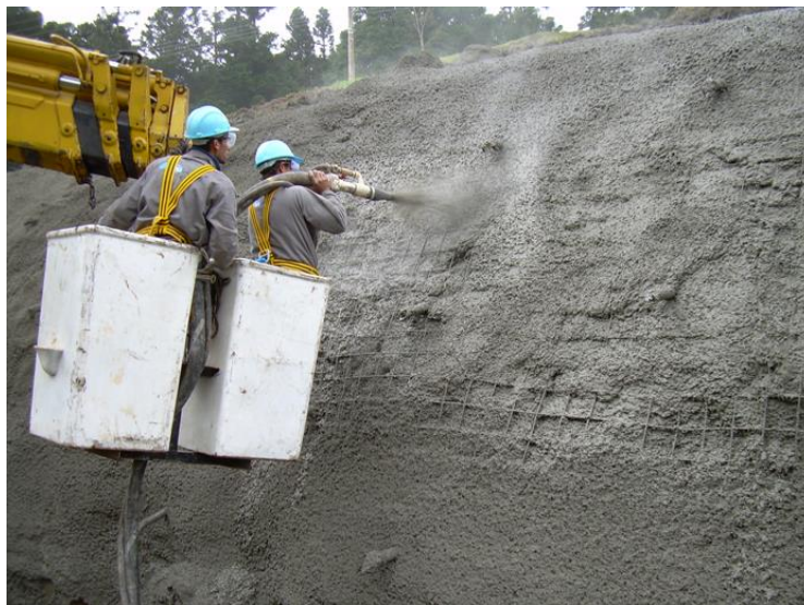
Figura 17 - Concreto projetado para a proteção de taludes ( https://www.prolazer.com.br/concretoprojetado/obras_realizadas.html 21/04/17, 16:51)
