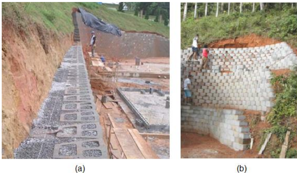
Figura 22 - (a) Vista lateral e (b) Vista frontal do revestimento da face do talude por blocos Terrae
