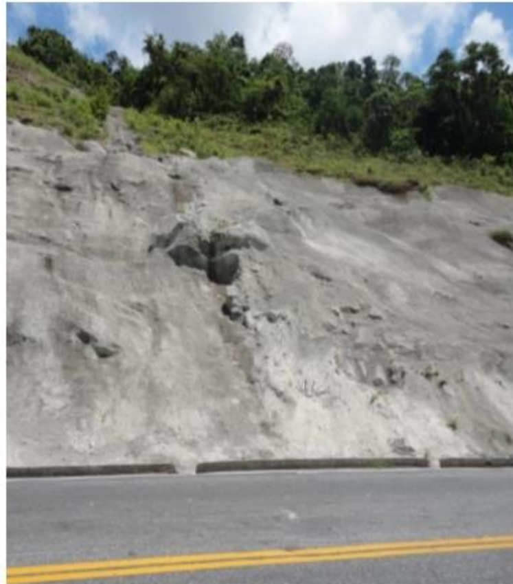
Figura 11 – Proteção superficial com o uso de concreto projetado (Freitas, 2013)
