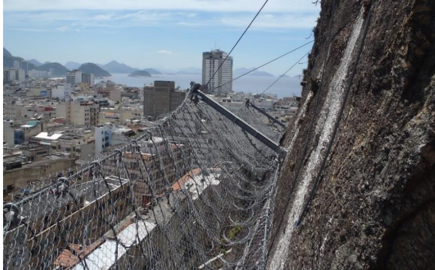
Figura 33 – Barreiras flexíveis de impacto instaladas no Morro do Cantagalo com face para a Rua Prof. Gastão Bahiana (GEOBRUGG, 2011)
