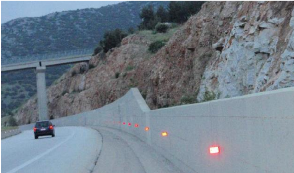
Figura 17 – Barreira rígida de impacto (Pantelidis e Kokkalin, 2011)
