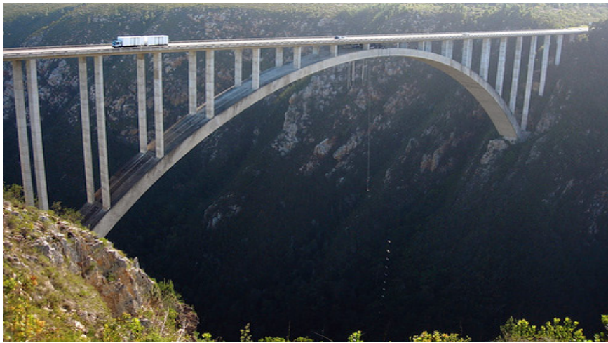
Figura 2.34 – Ponte Bloukrans. Disponível em: < http:// www.hottnez.com >
