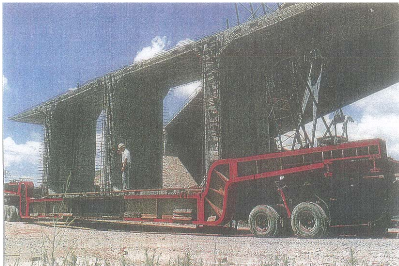
Figura 5.32 - Segmento pré-moldado da superestrutura do vão de acesso sobre o carregador (ROTOLONE, 1986).
