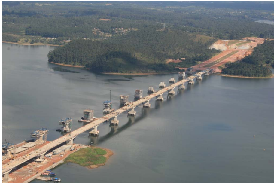
Figura 5.72 – Estrutura da ponte interna sobre a Represa Billings em fase de conclusão.
