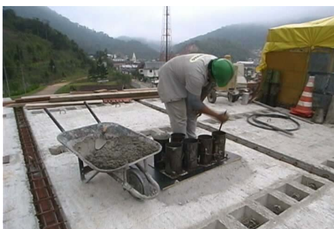
Figura 5.11 - Retirada de material para realização do controle tecnológico e ensaios de resistência com corpos de prova.
