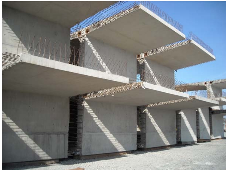
Figura 5.52 – Berço de estocagem das aduelas
