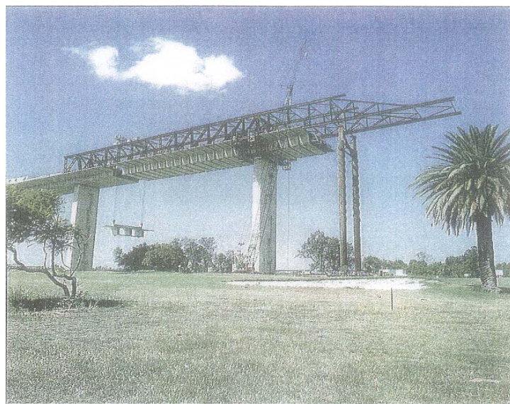
Figura 5.35 - Treliça de montagem antes do lançamento sobre os 88 metros de vão (ROTOLONE, 1986).
