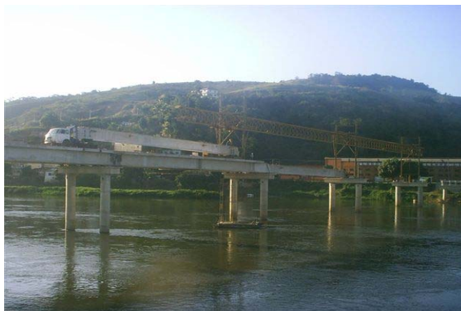
Figura 5.18 - Treliza de lançamento
