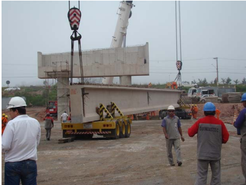
Figura 3.7 - Montagem de viga pré-moldada por meio de guindaste pelo solo (Obra Rodoanel Mario Covas, São Paulo, 2009).
