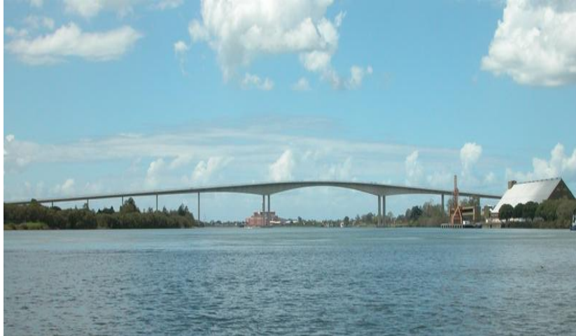
Figura 2.25 – Ponte Gateway, Brisbane. Disponível em: < http://www.en.structurae.de/structures >
