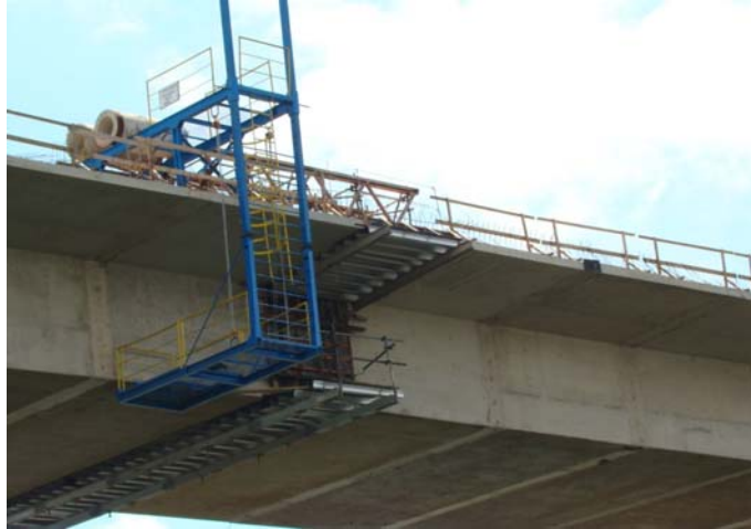
Figura 5.70 – Fechamento do vão central.
