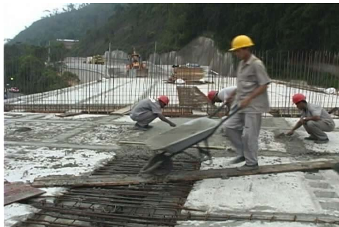
Figura 5.20 - Solidarização estrutural executada no local da obra.
