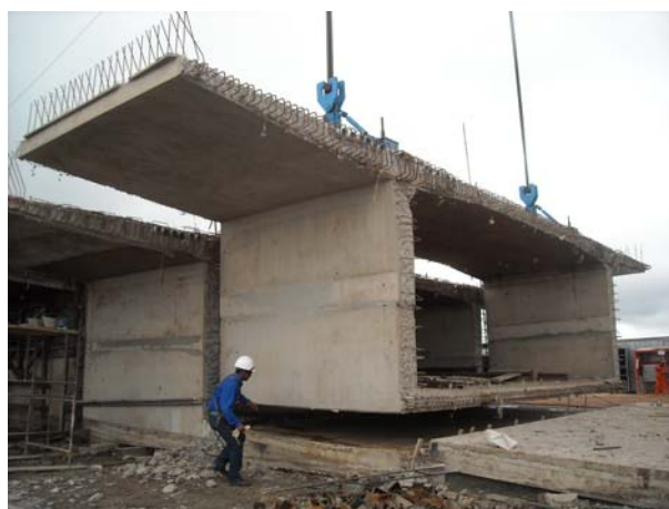
Figura 5.67 – Movimento inicial de descolamento do berço.
