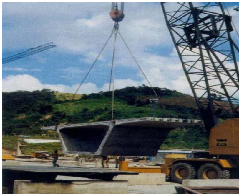
Figura 3.3 - Içamento de aduela pré-moldada (FIB, 2000 apud MATTOS, 2001).
