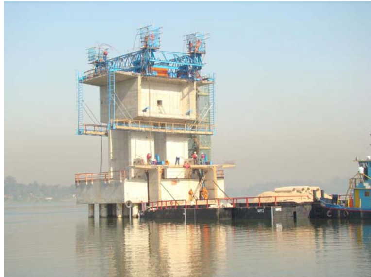
Figura 3.8 - Montagem por balsa (Obra Rodoanel Mario Covas, São Paulo, 2009).
