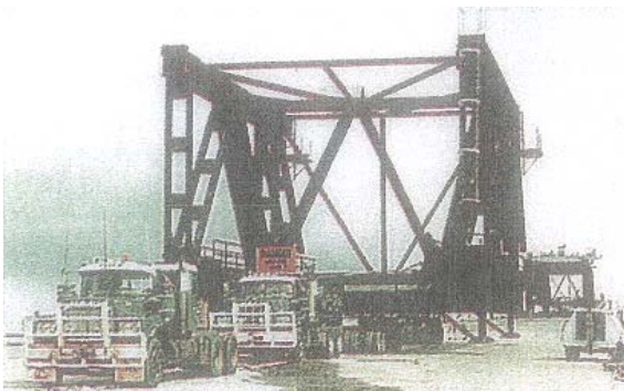
Figura 5.36 - Treliça de montagem sendo transportada para baixo dos vãos de acesso do lado sul (ROTOLONE, 1986).
