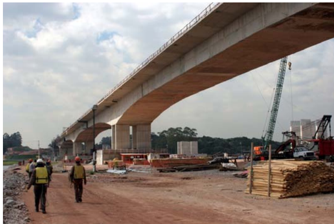
Figura 5.71 – Vão completo da ponte executado.
