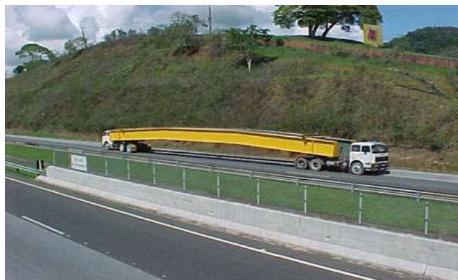
Figura 5.15 - Transporte da viga com dois tratores mecânicos
