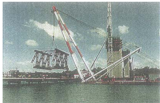
Figura 5.37 - Treliça de montagem sendo carregada pelo guindaste flutuante (ROTOLONE, 1986).
