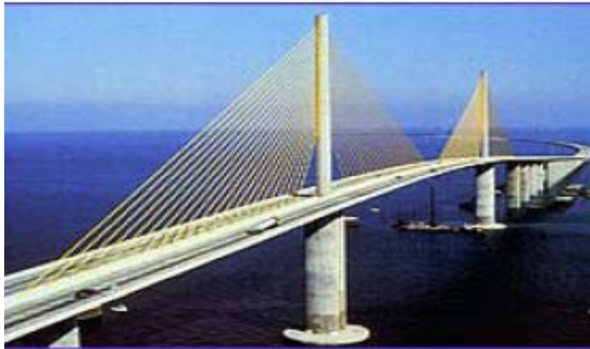
Figura 2.39 – Ponte Sunshine Skyway. Disponível em: < http:// www.pbs.org/wgbh/nova/bridge >
