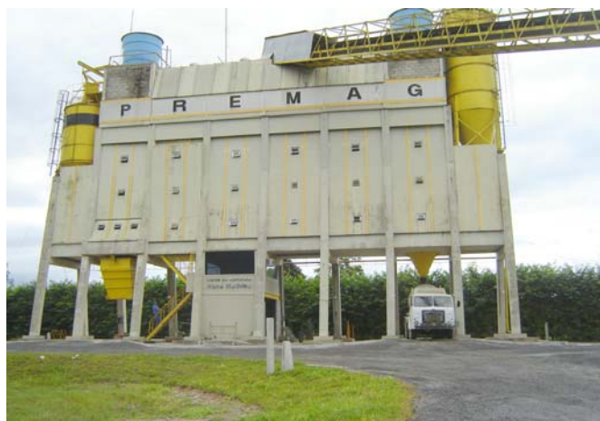
Figura 5.9 - Central de concreto
