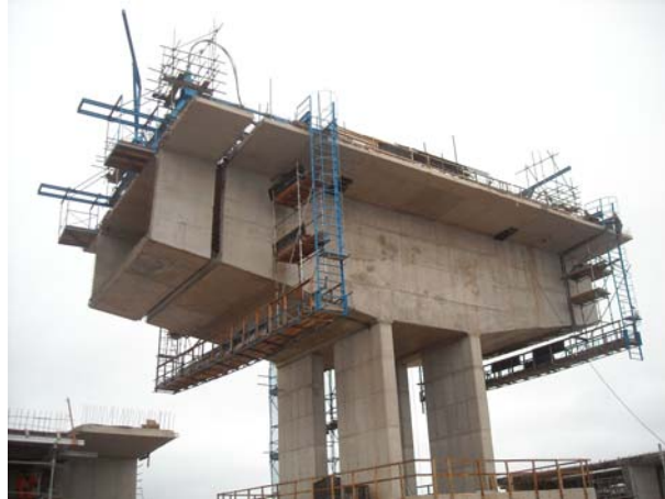
Figura 5.68 – Nivelamento e posicionamento final.
