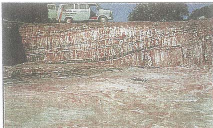
Figura 5.23 - Escavação para o Encontro A (HIGGINS; MATT, 1983).
