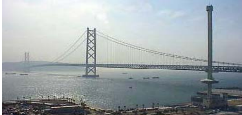
Figura 2.20 – Ponte Akashi Kaikyo. Disponível em: < http://www.engenhariacivil.wordpress.com >
