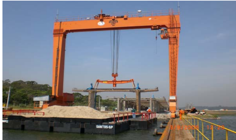
Figura 5.53 - Aduela sendo carregada, pelo pórtico Munck, do berço de estocagem até a balsa que a transporta ao local da montagem.
