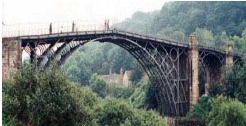
Figura 2.6 – Ponte sobre o rio Severn. Disponível em: < http://www.lmc.ep.usp.br >
