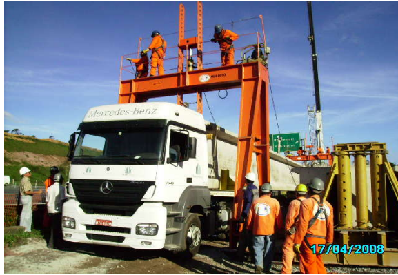
Figura 5.47 – Viga retirada do berço para transporte ao local da montagem.
