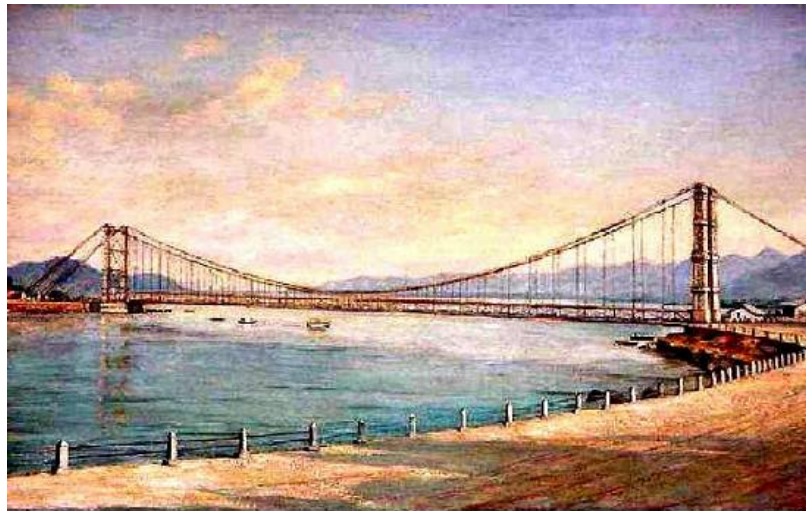
Figura 2.19 – Ponte de São Vicente. Disponível em: < http://www.wikipedia.org >
