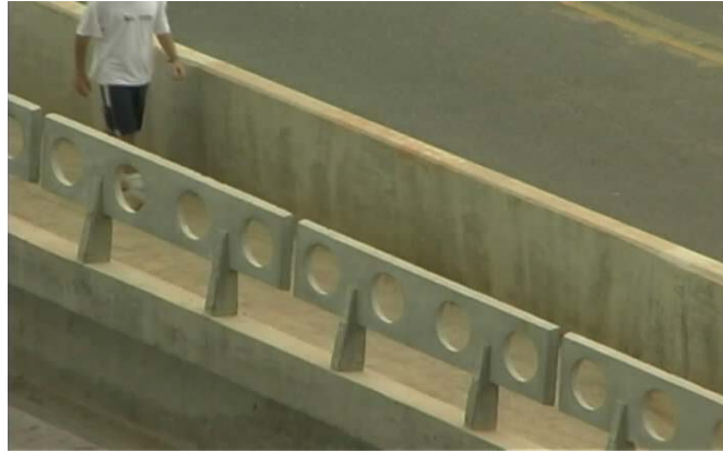
Figura 5.21 - Barreiras e guarda-corpos.
