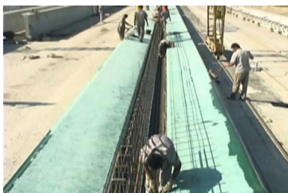
Figura 5.8 - Conferência das fôrmas e das armaduras na pista de fabricação.
