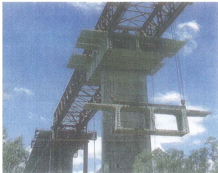
Figura 5.34 - Segmento pré-moldado da superestrutura do vão de acesso sendo levantado pela treliça de montagem (ROTOLONE, 1986).
