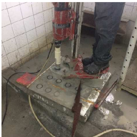
Figura 65 – Execução das semicarotagens
