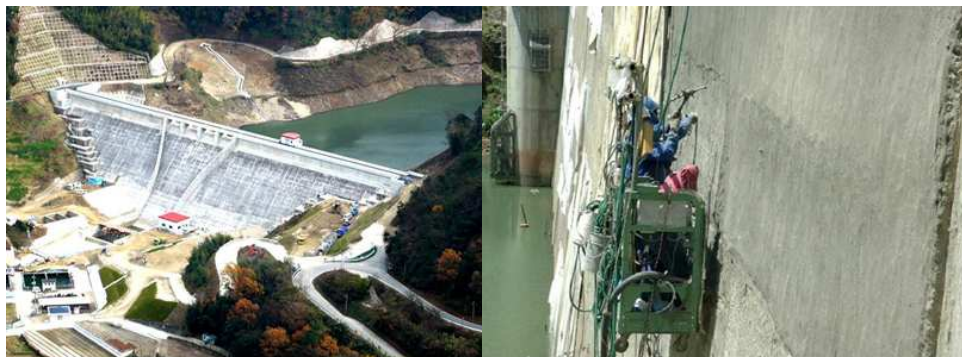
Figura 3 – Reparo da represa Mitaka, Japão (KOJIMA et al, 2004).
