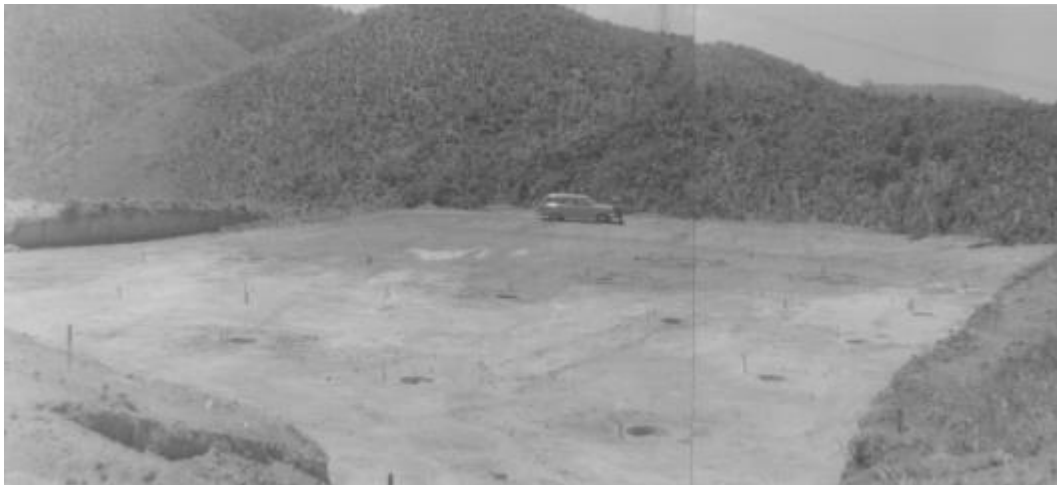
Figura 20 - Local das provas de carga / Platô com fundações locadas Danziger (1983)
