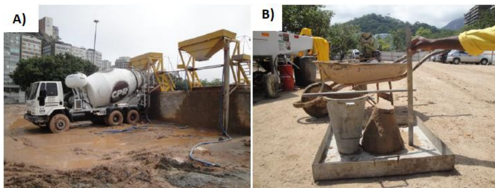
Figura 13 – a) Preparação do geogROUT no caminhão betoneira, b) Slump-test (Adaptado de Mello, 2013)
