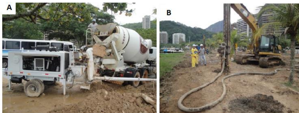
Figura 14 - a) Bombeamento do geogROUT , b) Equipamento de bombeamento de geogROUT (adaptado de Mello, 2013)
