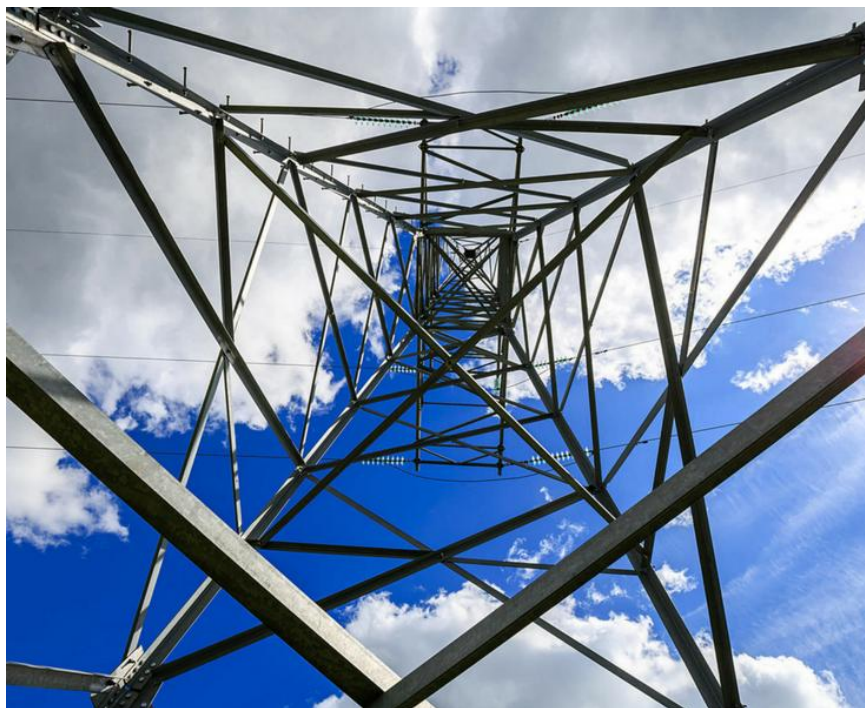
Figura 5 – Perfil metálico cantoneira como elemento estrutural em torres de transmissão de energia [6].
