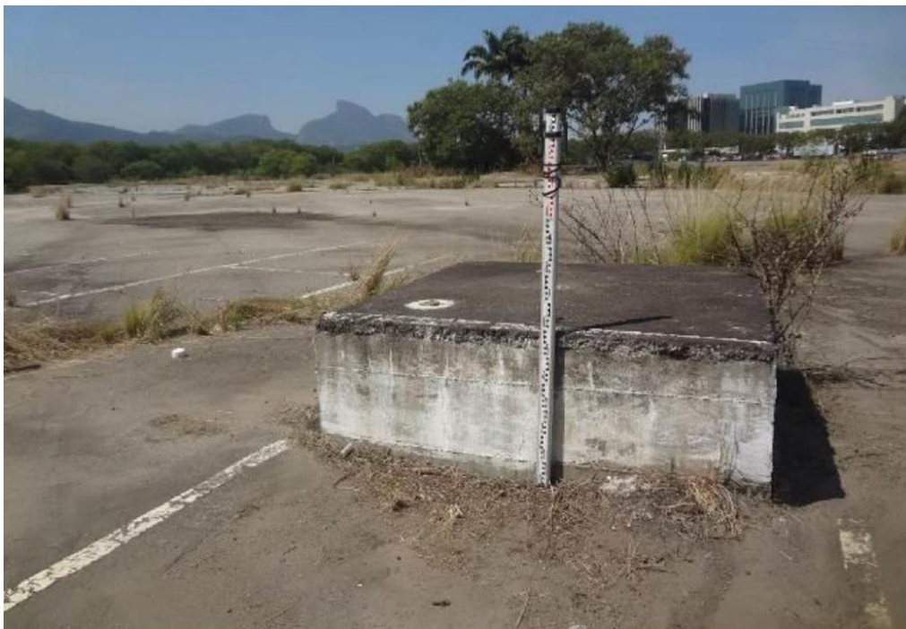
Figura 4 - Recalque em estacionamento do Terra Encantada, Barra da Tijuca – RJ
