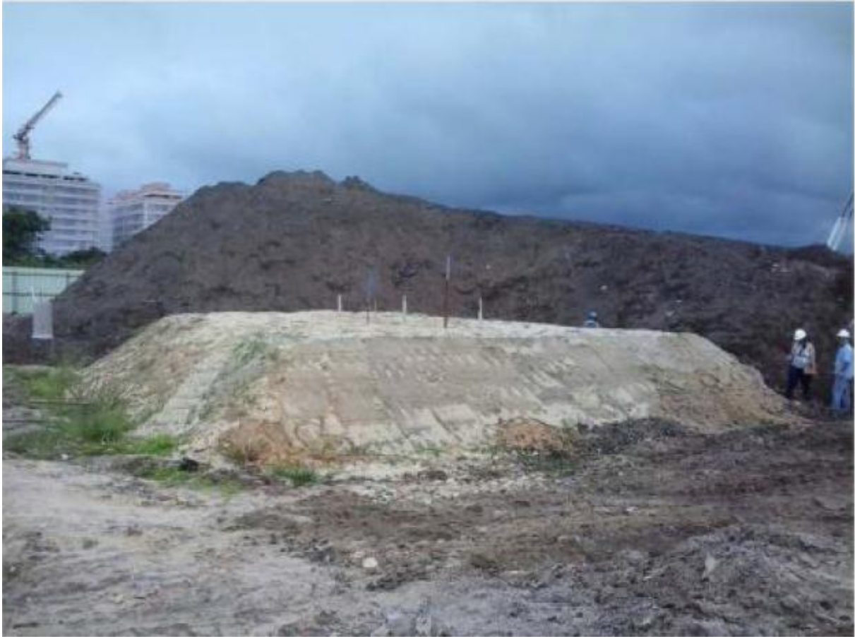
Figura 21 - Depósito de material a esquerda de aterro experimental sem tratamento
