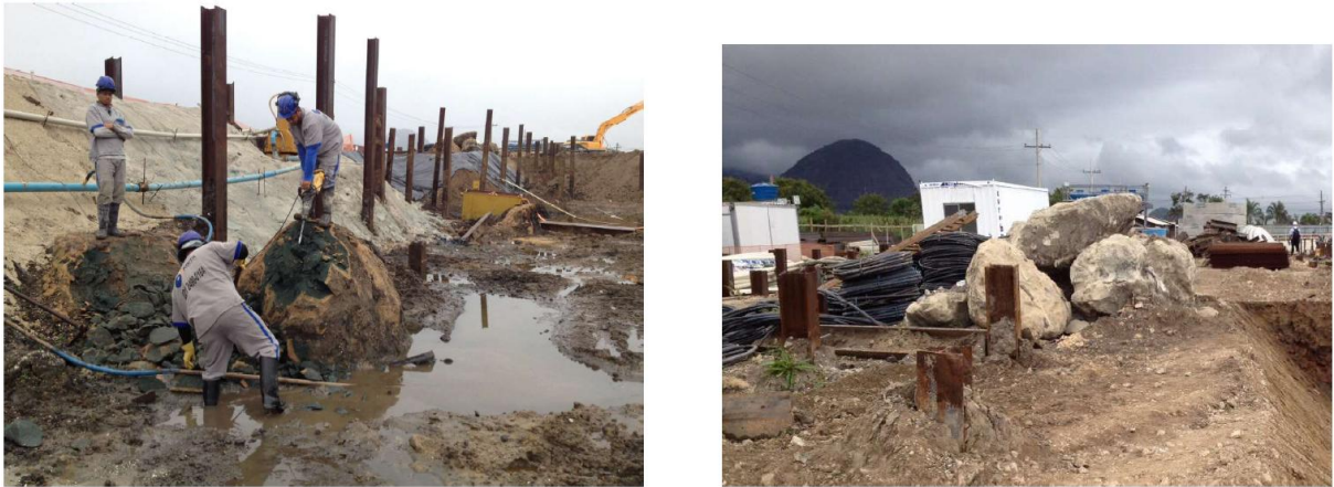
Figura 7 - Bulbos de GeogROUT escavados
