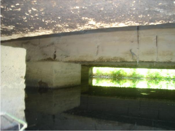
Foto 4.5 - Vista Parcial Inferior. Detalhe para os blocos do encontro. Notar pontos de corrosão da armadura de pele.
