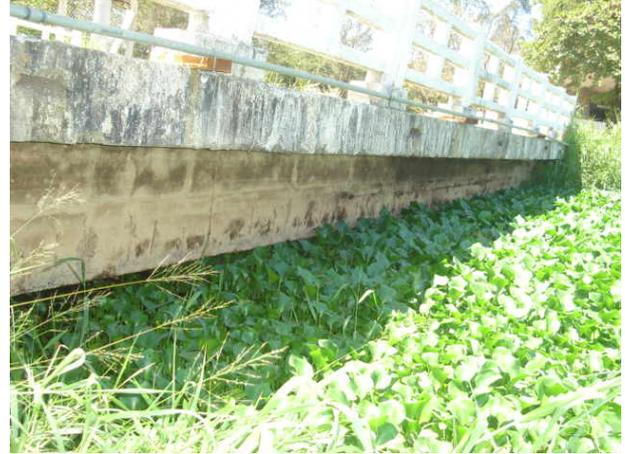
Foto 4.6 - Vista parcial da laje em balanço e viga longarina VL1 externa. Notar baixo gabarito vertical em relação ao canal.
