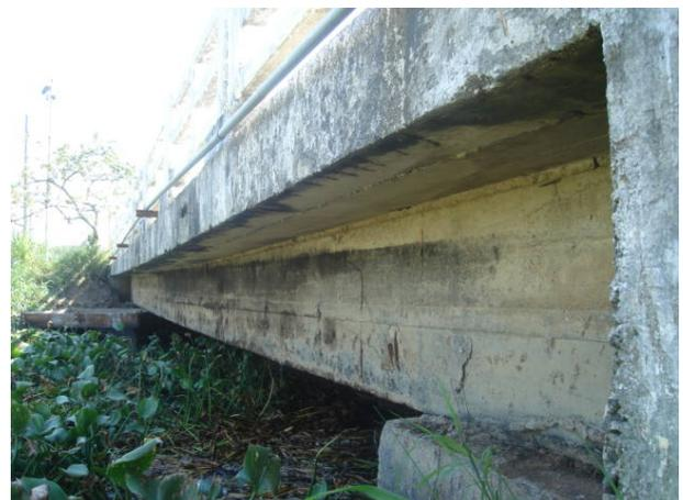
Foto 4.4 - Vista de laje em balanço e viga longarina VL4 externa.
