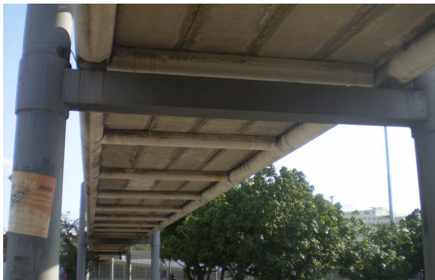
Figura 26 – Vista inferior da passarela
