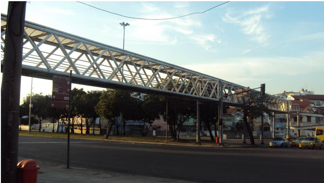
Figura 23 – Vista lateral oeste da passarela
