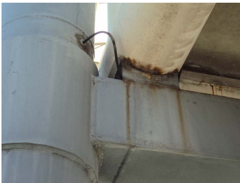
Figura 29 – Vista da ligação com neoprene
