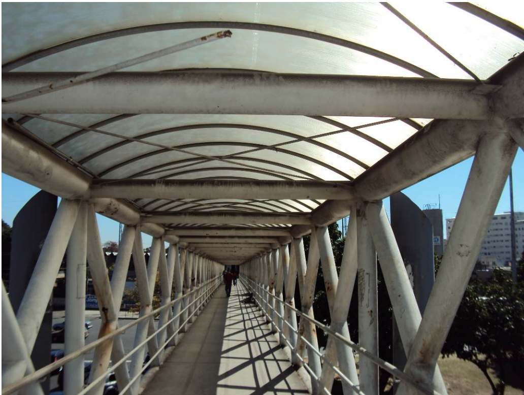
Figura 25 – Vista interna da passarela
