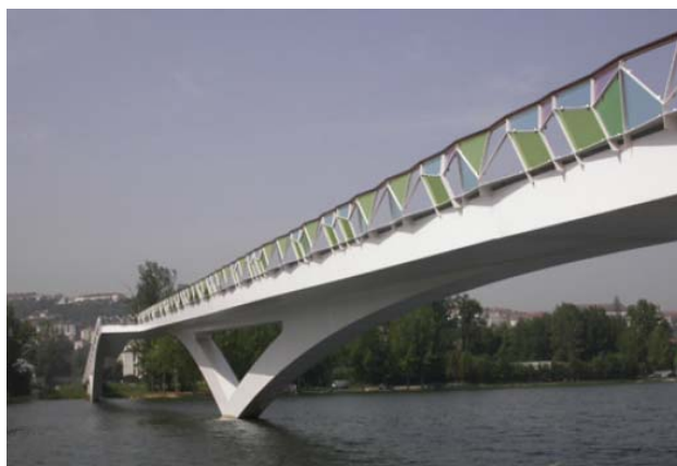
Figura 10 – Vista lateral da passarela Pedro e Inês [5]
