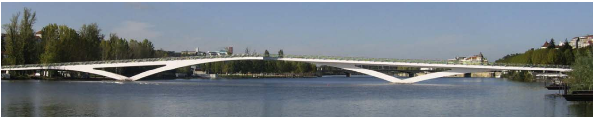
Figura 8 – Vista geral da passarela Pedro e Inês [5]
