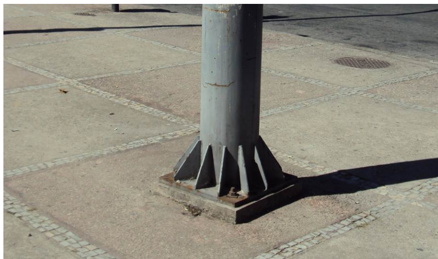
Figura 28 – Vista da base da passarela
