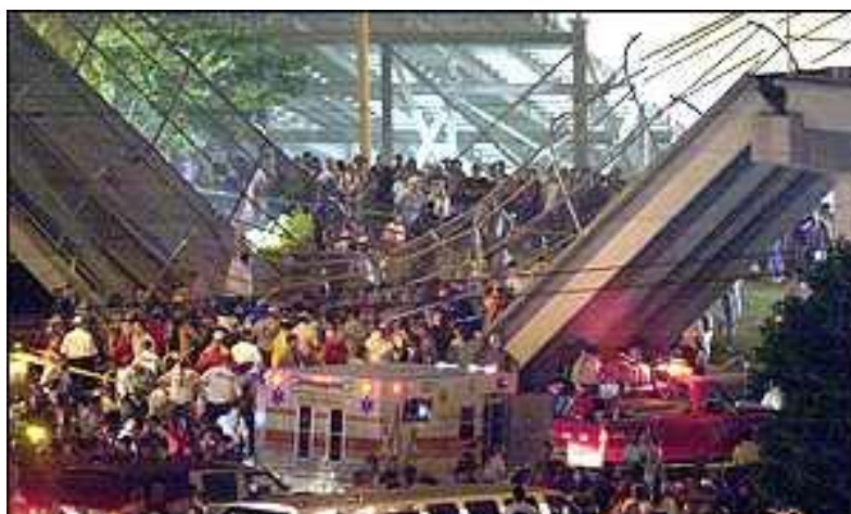
Figura 1 – Desabamento de uma passarela na Carolina do Norte/EUA [1]
