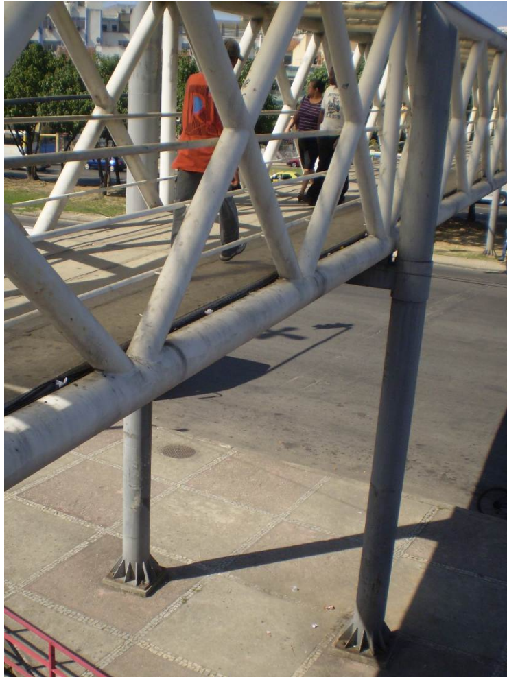
Figura 27 – Vista do pórtico da passarela
