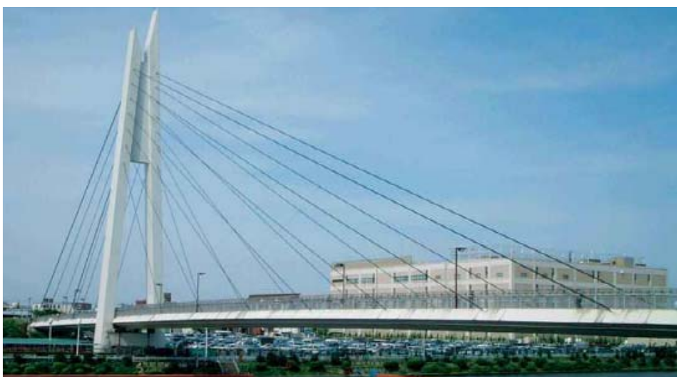
Figura 6 – Vista lateral da passarela Toda Park Bridge (Nakamura e Fujino [4])
