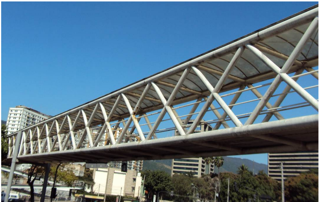
Figura 24 – Vista lateral leste da passarela
